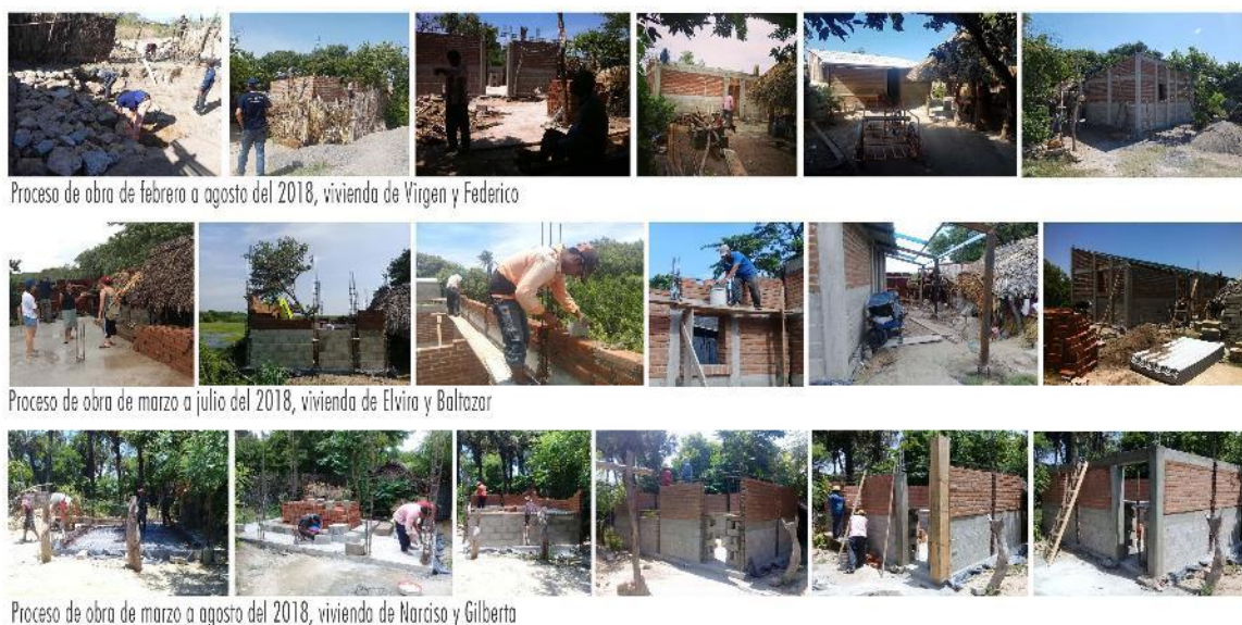
Imágenes 22. Compilado de procesos de obra. Gráfico: Reconstrucción.istmo ITESO
