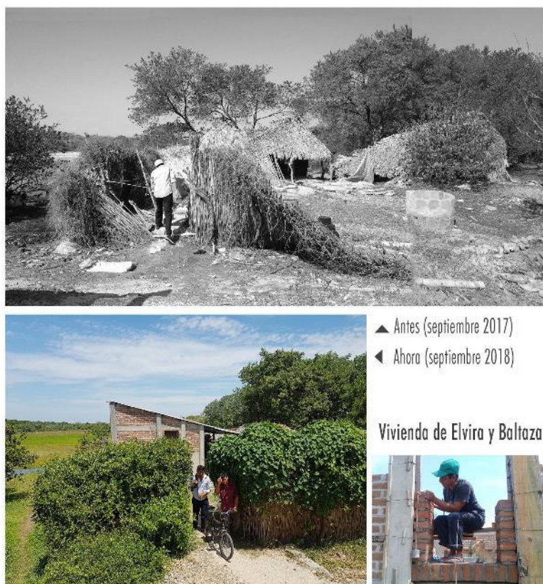
Imagen 5. Estado anterior y actual de la vivienda de Elvira y Baltazar. Gráfico: Reconstrucción.istmo ITESO
