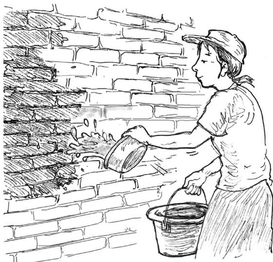
Mojamos la pared hasta lograr la humedad necesaria que facilite la adherencia del repello.
