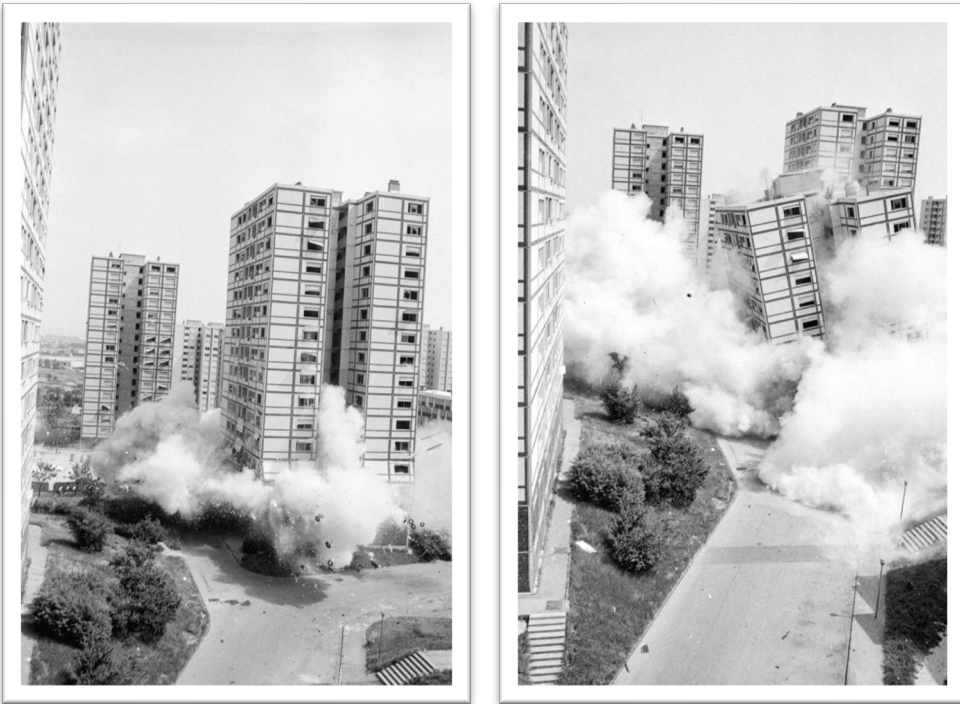
El 9 de junio de 1983, la Torre 6 del barrio de Minguettes en Vénissieux (Ródano) fue demolida en el marco de una importante operación de renovación urbana. Créditos: Bibliothèque Municipale de Lyon, archivos del Journal Rhône-Alpes.
