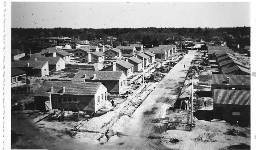
Los Castores son un movimiento cooperativo de autoconstrucción que surgió tras la Segunda Guerra Mundial en respuesta a la crisis de la vivienda. Aquí se construye una urbanización en la ciudad de Pessac (Gironde). Créditos: Association culturelle des Castors de Pessac.
