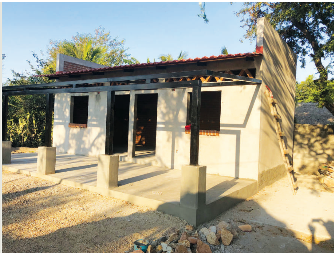
Vivienda terminada, San Mateo del Mar, Oaxaca Fotografía: Georgina Sandoval
