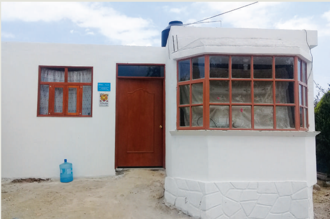
Vivienda concluida para familia beneficiaria, Totolapan, Morelos Fotografía: Casa y Ciudad
