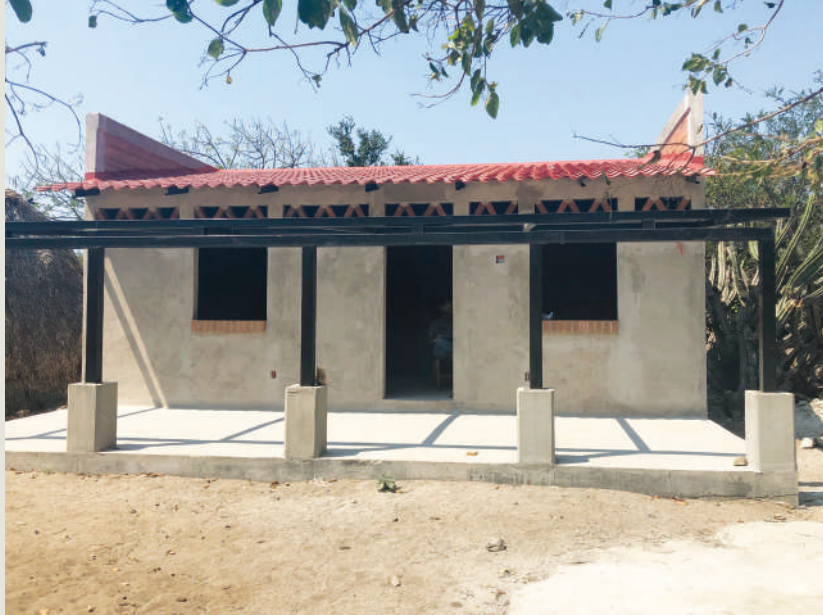
Vivienda terminada para familia beneficiaria, San Mateo del Mar, Oaxaca Fotografía: Georgina Sandoval
