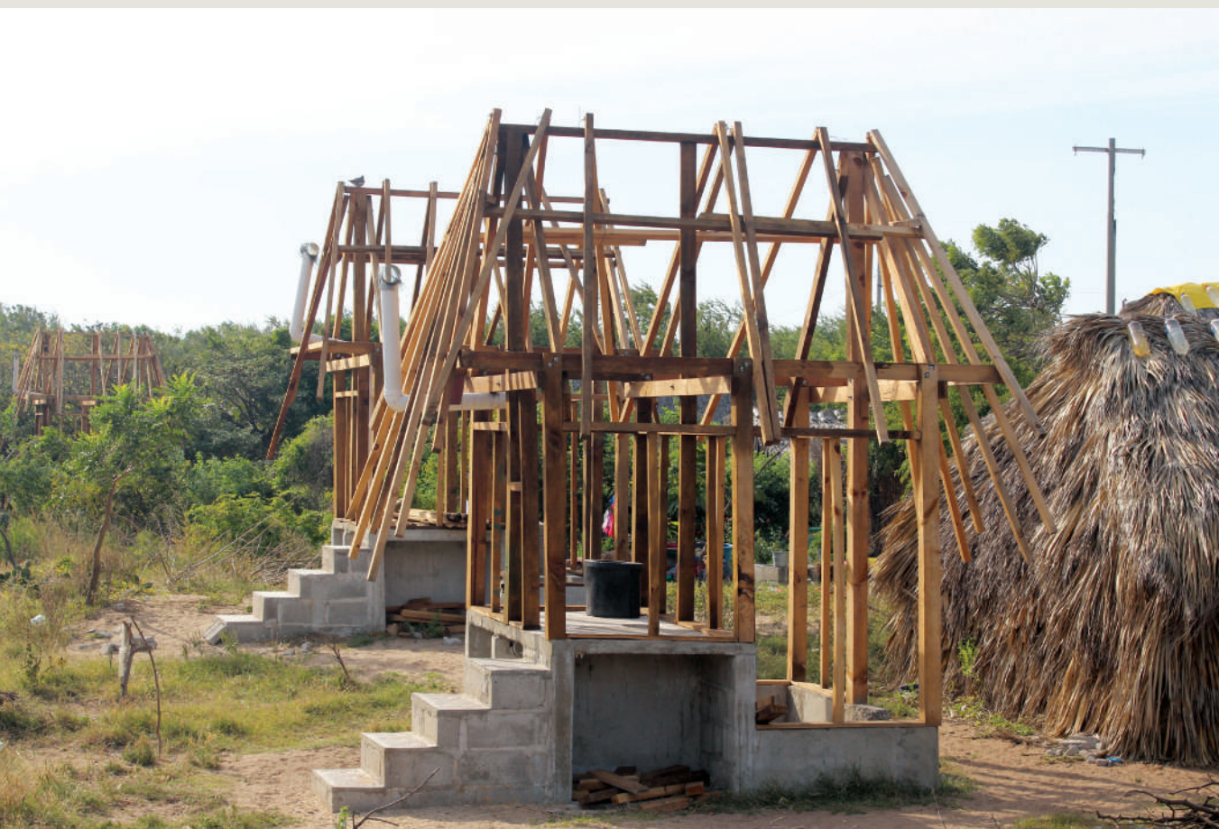
Proceso de construcción de sanitarios secos, San Mateo del Mar, Oaxaca Fotografía: Copevi
