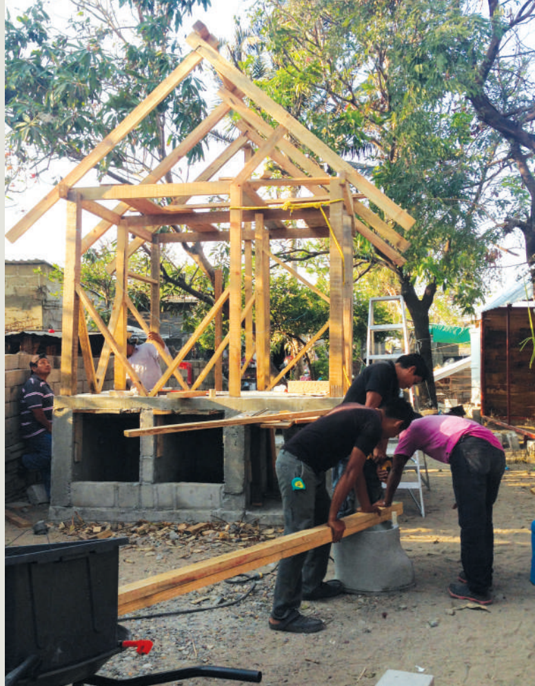
Proceso de construcción de sanitarios secos, San Mateo del Mar, Oaxaca Fotografía: Copevi
