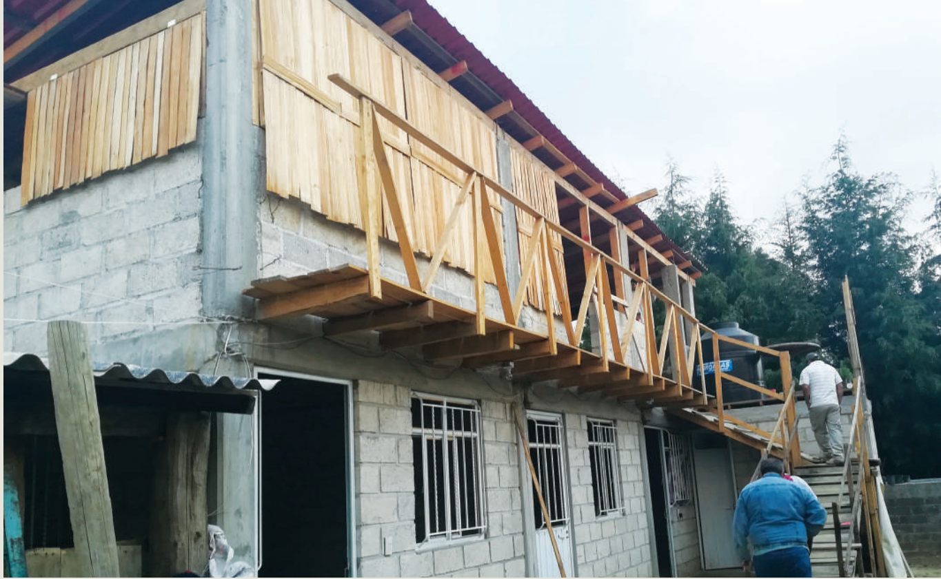
Vivienda en proceso de construcción, Hueyapan, Morelos Fotografía: Casa y Ciudad
