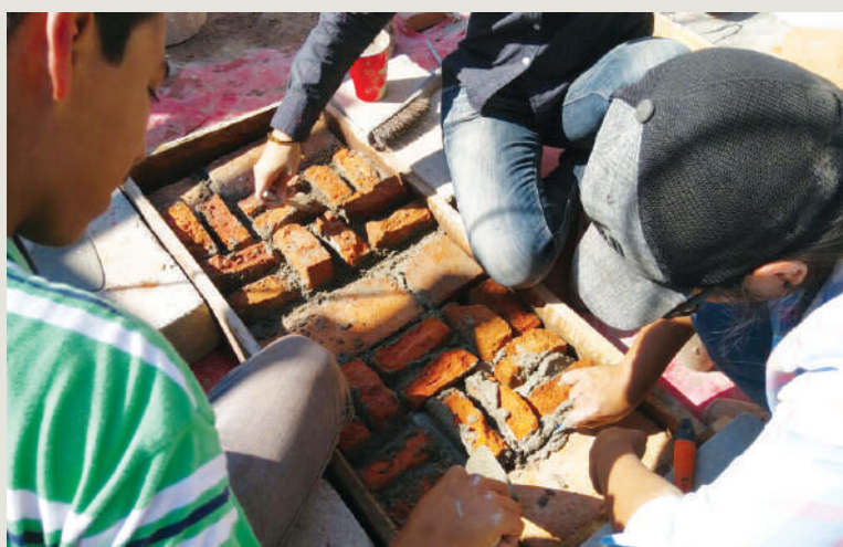
Estudiantes elaborando placa para muro térmico, "Un Cuarto Más" para Damnificados Fotografía: MALH
