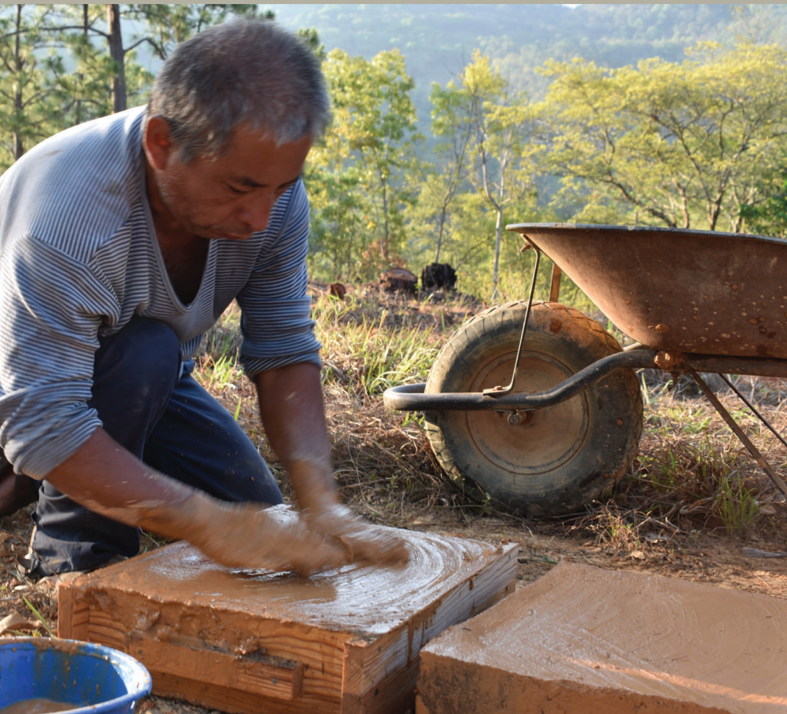
Construcción de adobes Santa María Coatlán, Oaxaca Fotografía: Comunal
