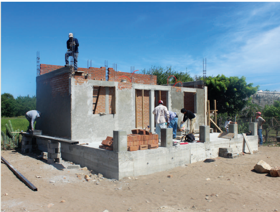
Construcción de vivienda reforzada, San Mateo del Mar, Oaxaca Fotografía: Narciso Cuevas
