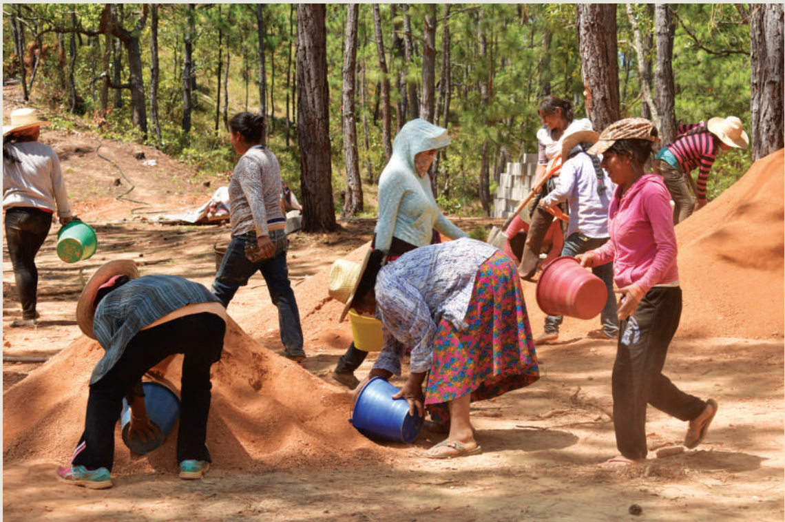
Proceso de construcción de adobes en la comunidad, Santa María Coatlán, Oaxaca Fotografía: Comunal
