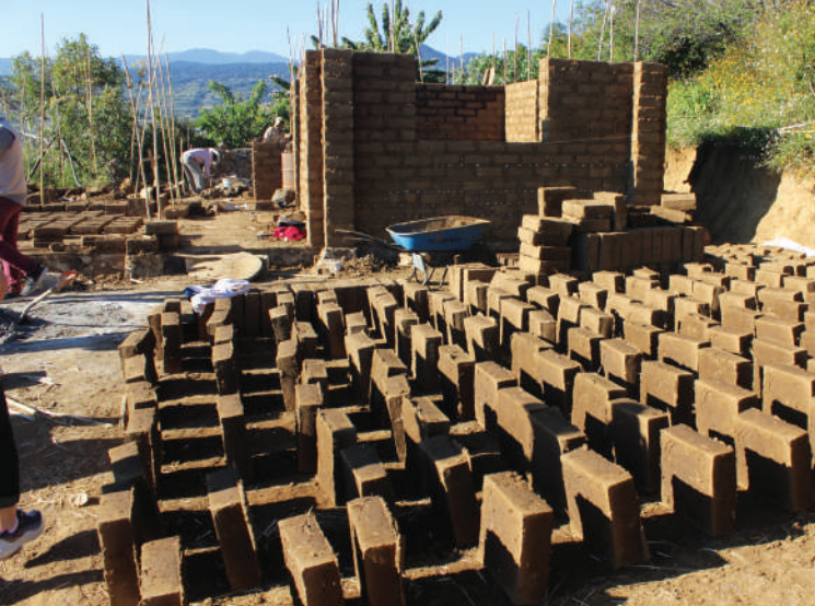
Producción de adobes para vivienda de sistema constructivo mixto con adobe y bajareque, Totolapan, Morelos Fotografía: Narciso Cuevas
