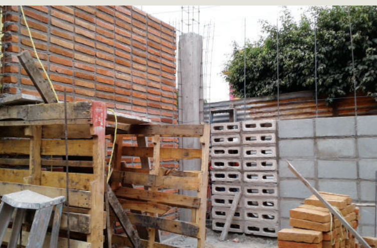
Muro armado ladrillo y bloques, "Un Cuarto Más" para Damnificados Fotografía: MALH
