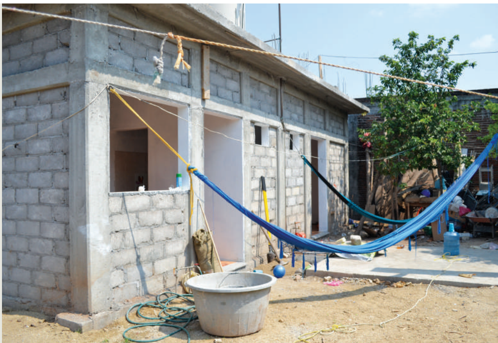
Vivienda YOO' en proceso de construcción Fotografía: Mejoremos
