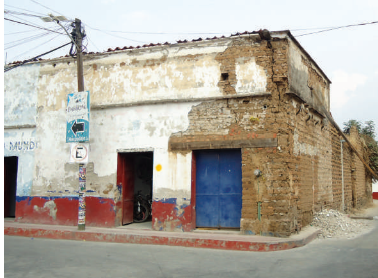
Recuperación y reconstrucción de vivienda antigua, Totolapan, Morelos Fotografía: Casa y Ciudad
