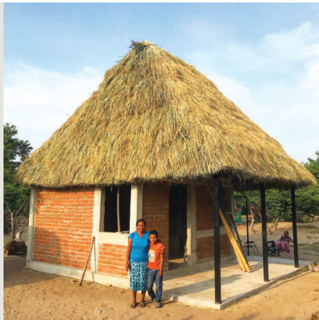
Vivienda híbrida tradicional concluida, San Mateo del Mar, Oaxaca Fotografías: Equipo de reconstrucción Istmo, ITESO
