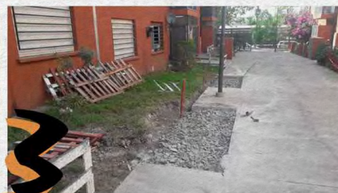
3 PREPARAR EL ÁREA PARA COLOCAR EL NUEVO PISO
