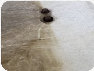
MANCHAS MÁS OSCURAS O CLARAS QUE EL RESTO DE LA SUPERFICIE, CON UN ANILLO MANCHADO DE SUCIEDAD ALREDEDOR
