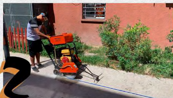
2 CORTAR O RETIRAR EL PISO IMPERMEABLE EXISTENTE
