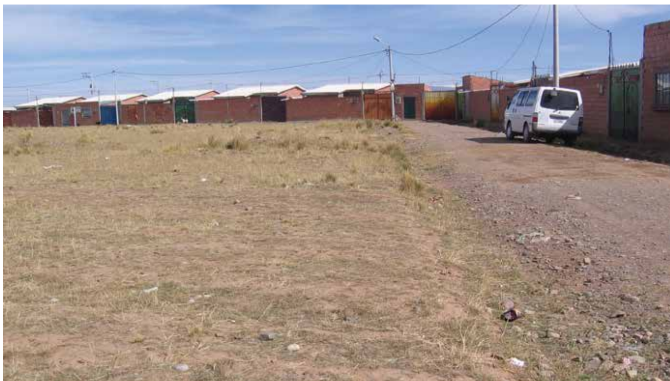
Ilustración 7.- Estado de la infraestructura social (equipamiento vial)
