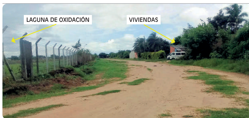
Fotografía 3 Calle principal barrio 14 de Agosto
