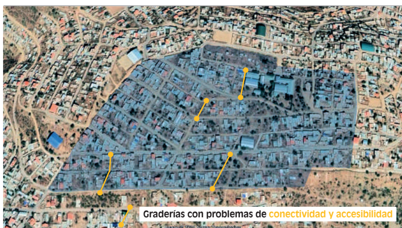
Ilustración 6 Graderías con problemas de accesibilidad y baja consolidación vial en Alto Mirador Ticti Sud
