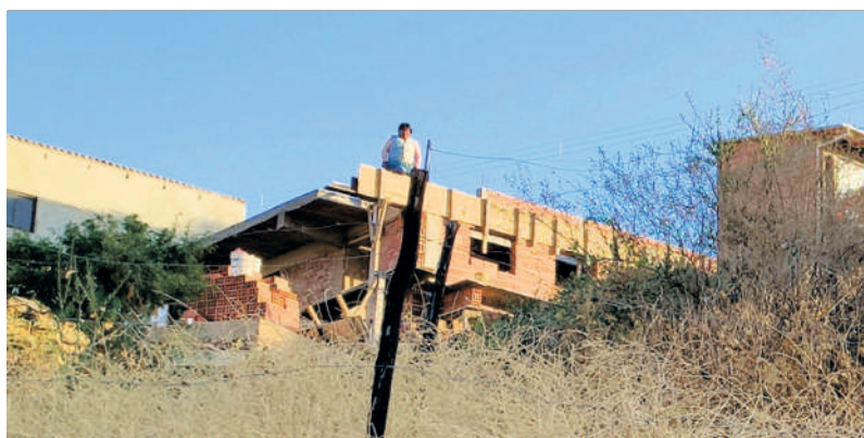
Fotografía 11 Vivienda en construcción en Alto Mirador Ticti Sud
