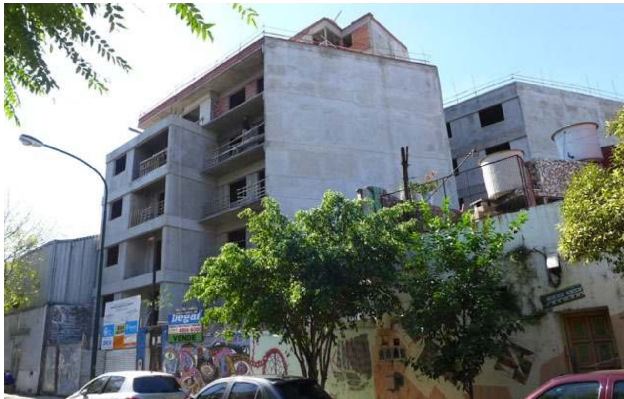
Frente lateral del inmueble en obra
