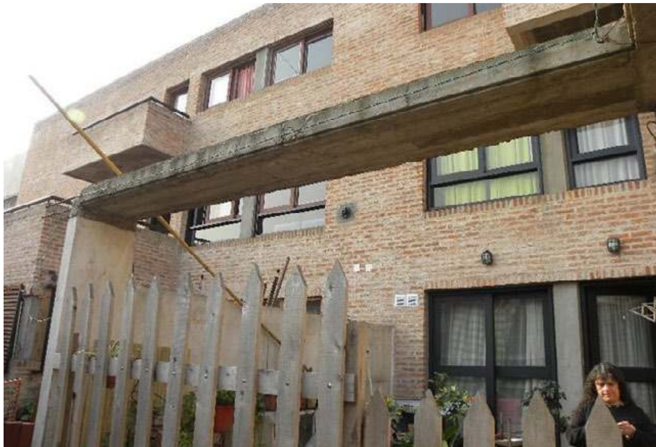
Frente lateral interno del inmueble en obra
