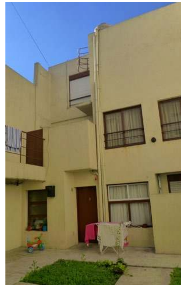
Contrafrente del complejo habitacional
