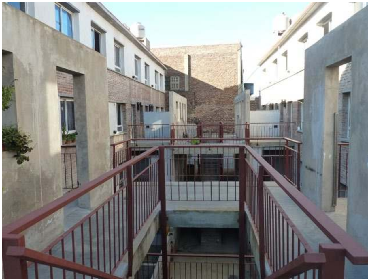
Escaleras de circulación interna
