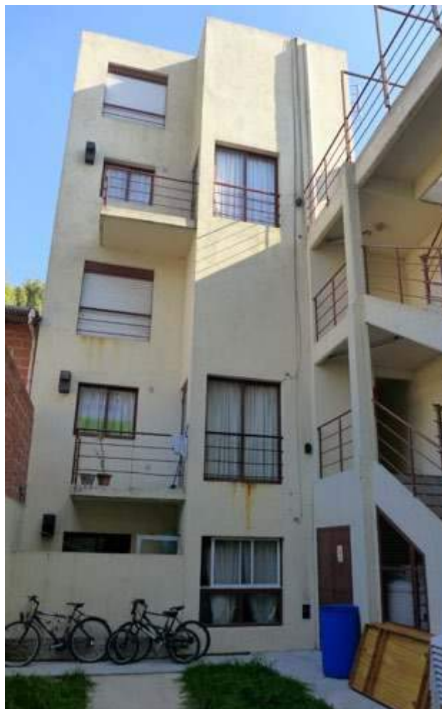
Contrafrente del complejo habitacional
