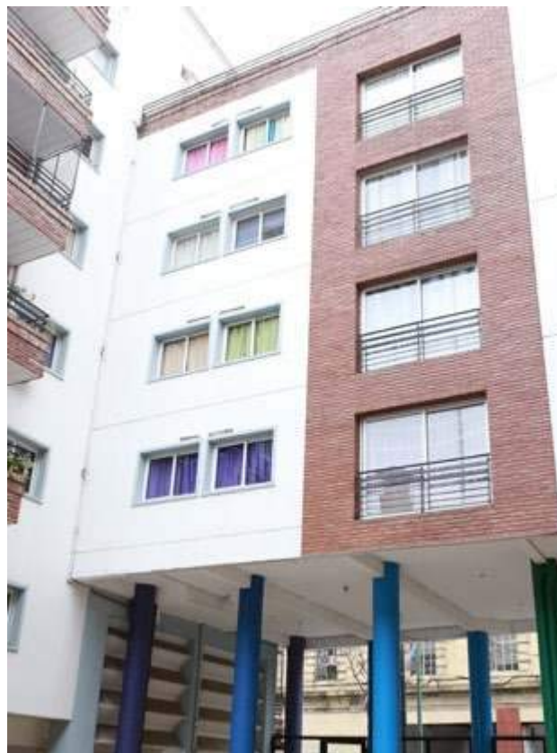
Contrafrente del complejo habitacional
