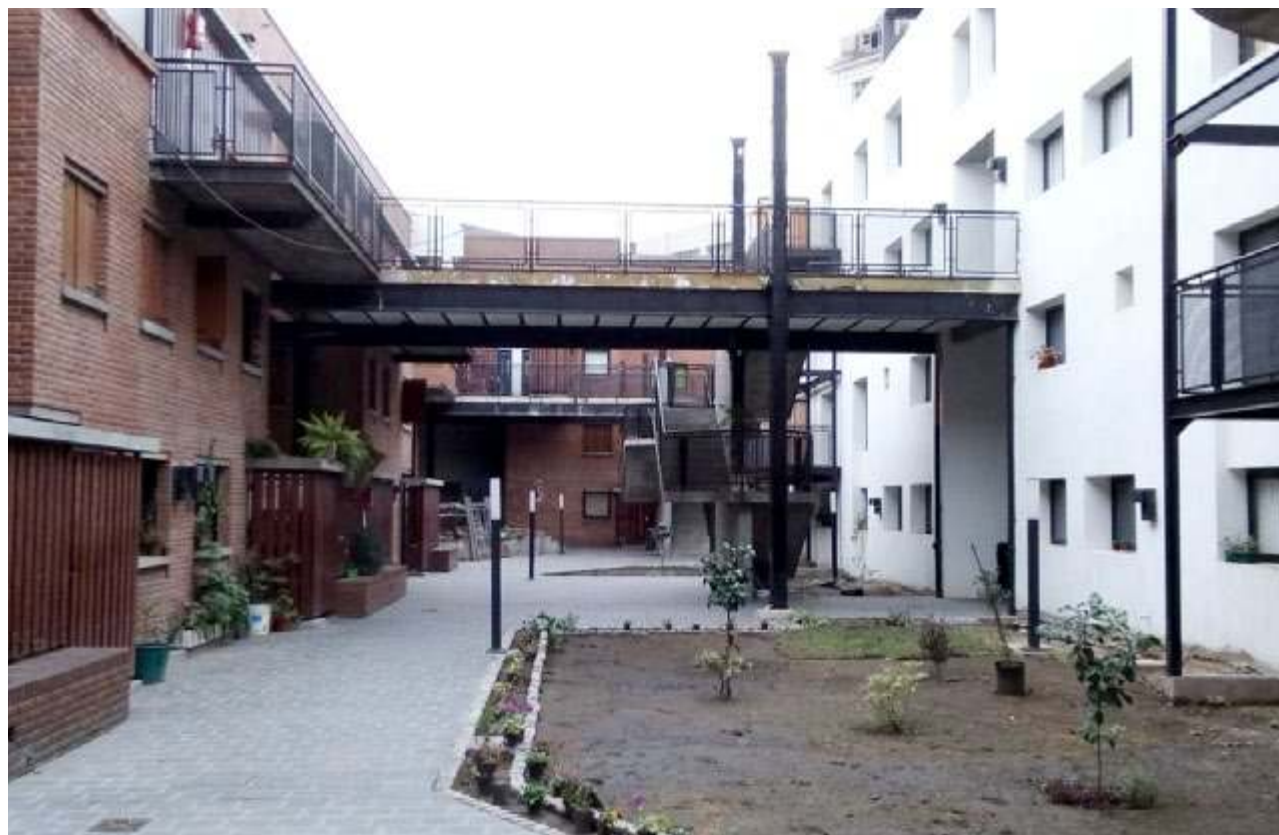
Pasillo interno de circulación
