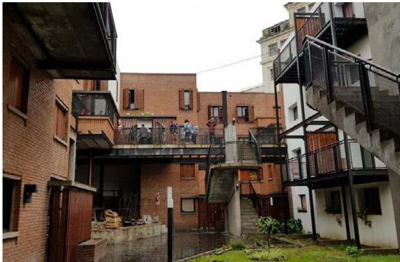
Pasillo interno de circulación
