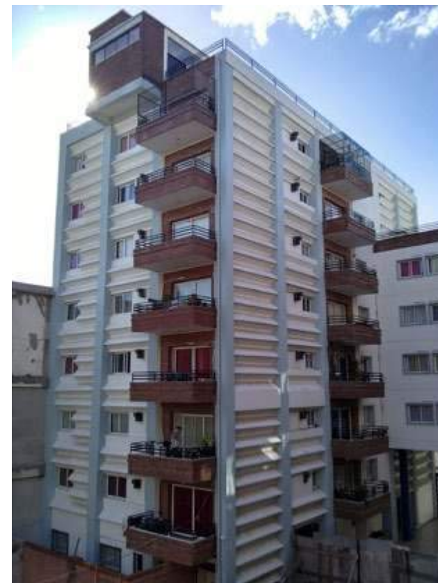
Contrafrente del complejo habitacional
