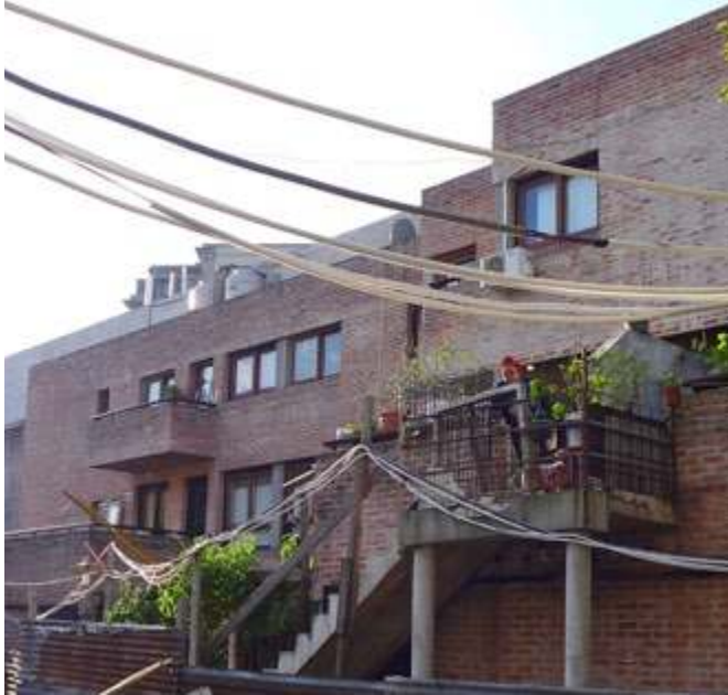
Frente lateral interno del inmueble en obra
