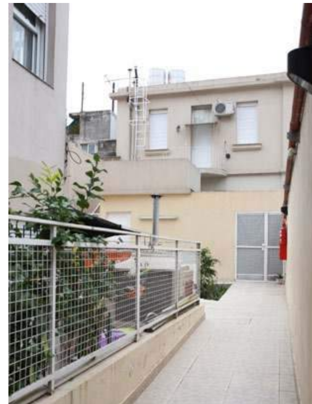
Pasillo interno de circulación
