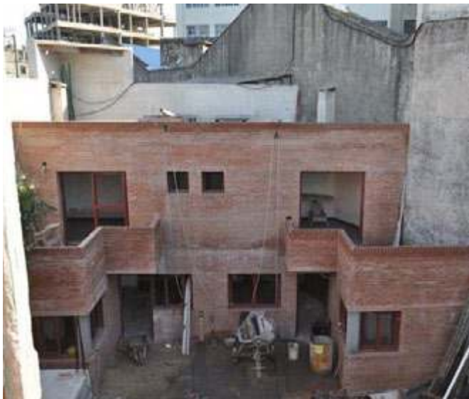
Modulo del fondo en obra
