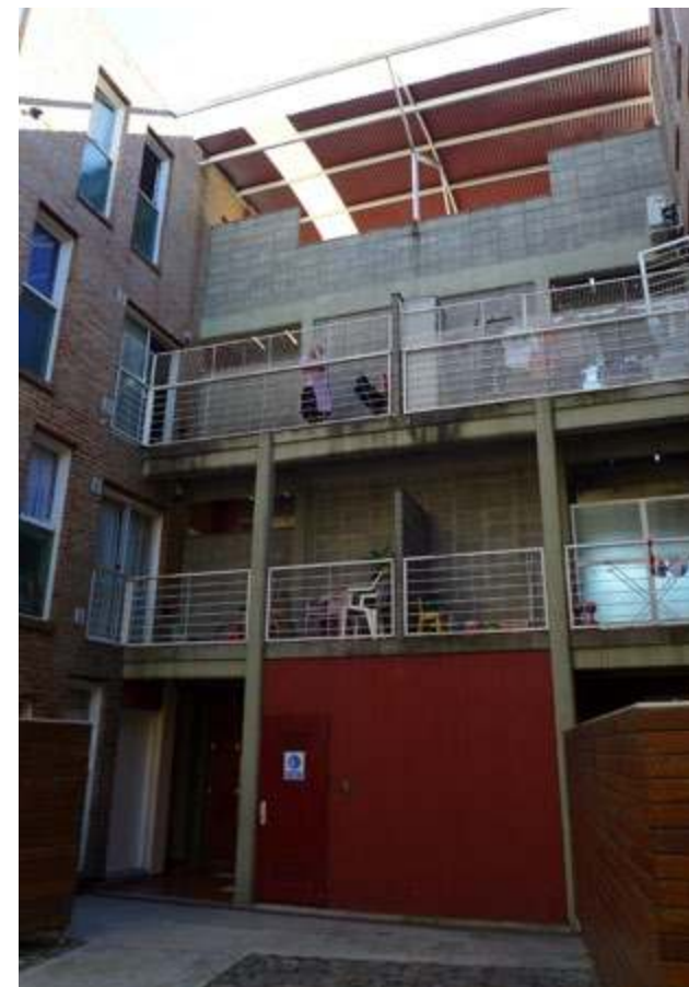
Contrafrente del complejo habitacional
