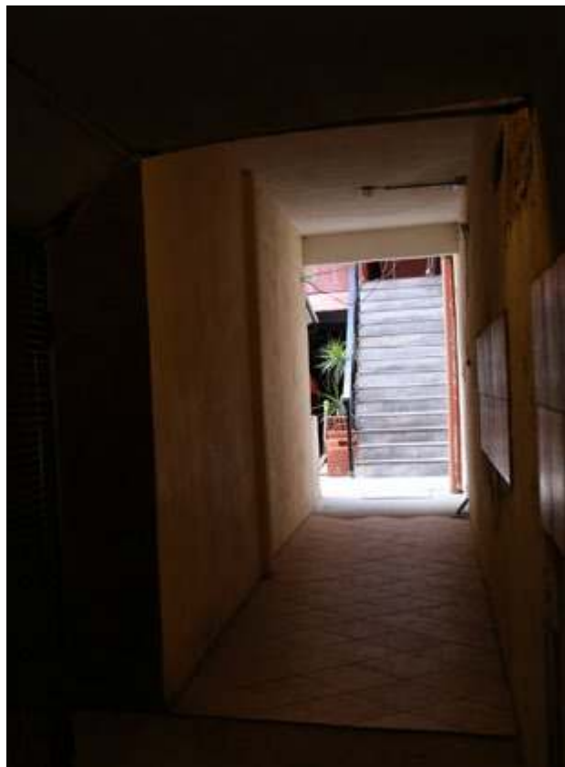
Pasillo de circulación interno
