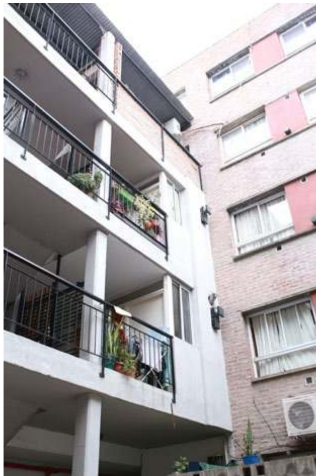
Contrafrente del complejo habitacional
