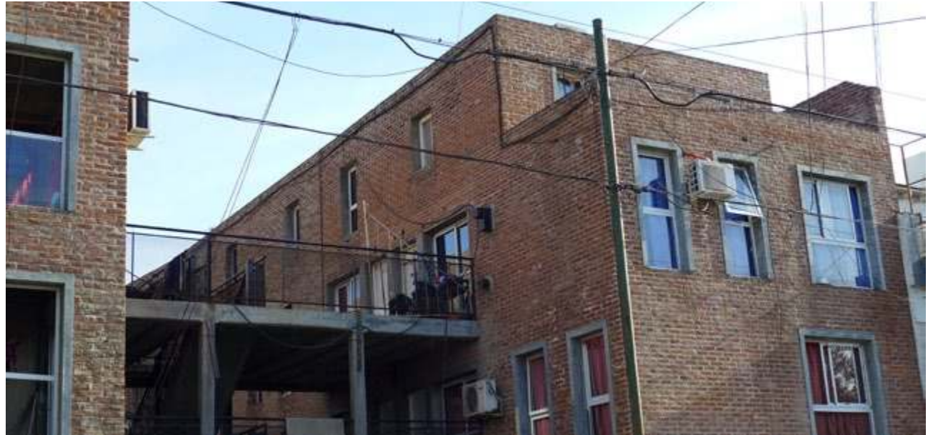
Vista lateral interno del inmueble
