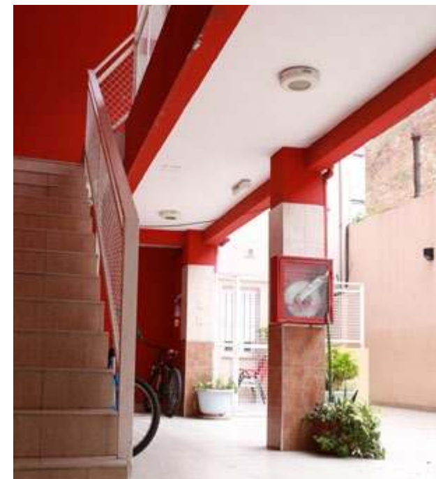
Patio y escalera de circulación interna
