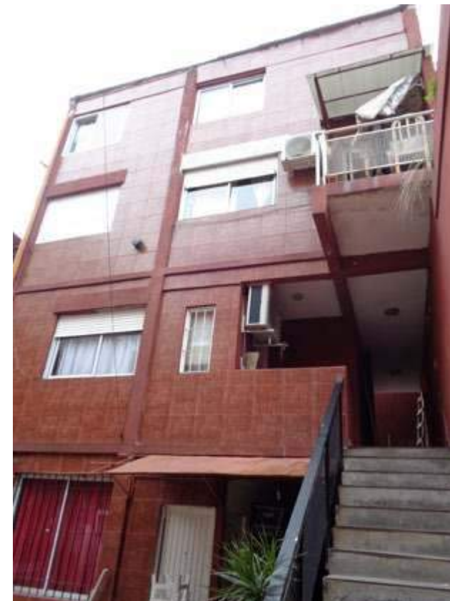
Contrafrente del complejo habitacional
