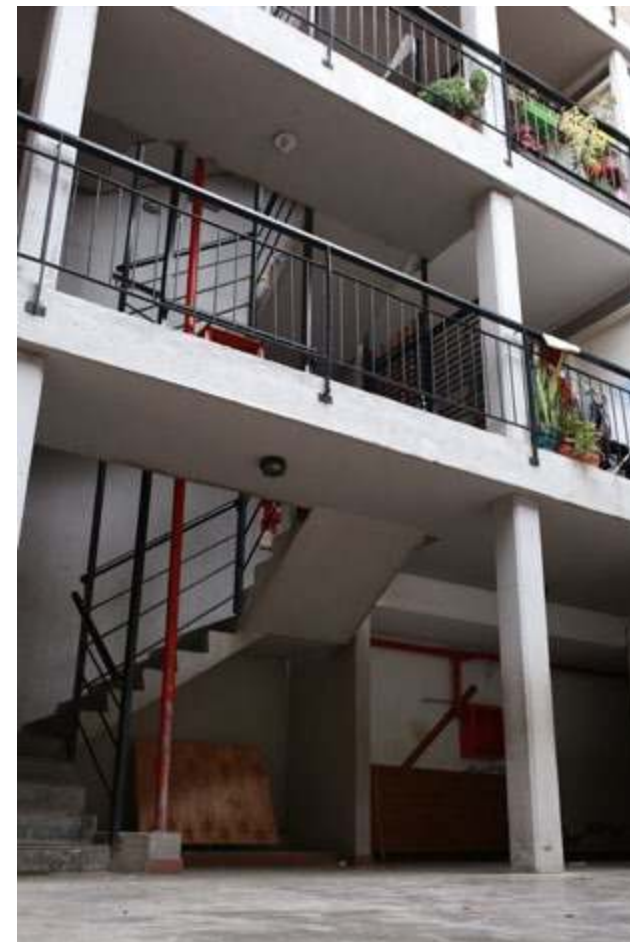
Escaleras de circulación interna
