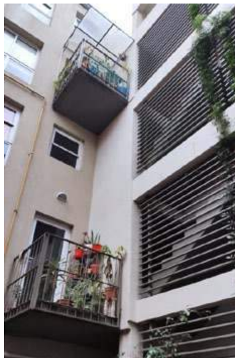
Vista desde pasillo interno
