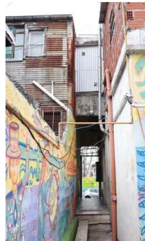
Pasillo de circulación
