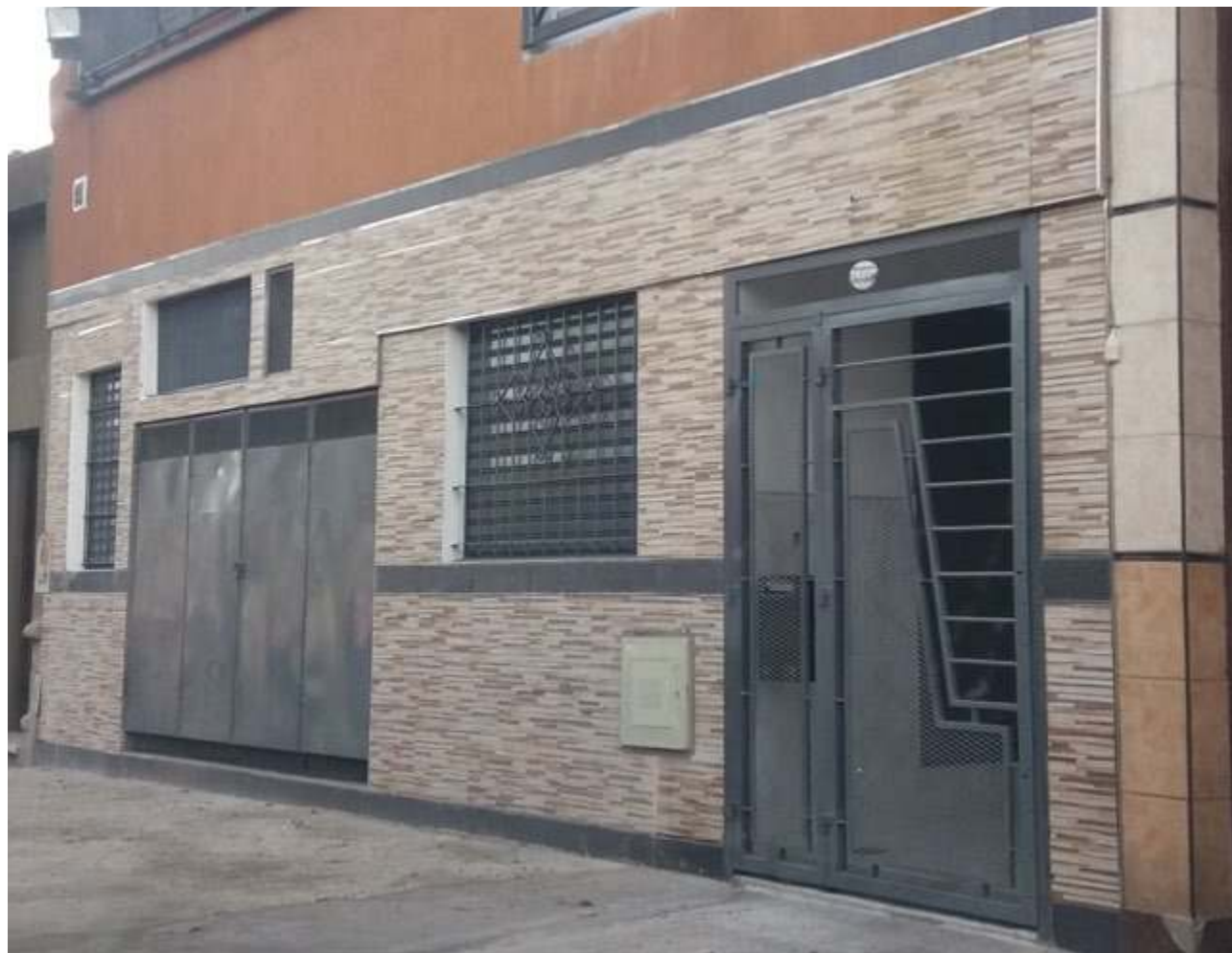
Vista fachada del edificio
