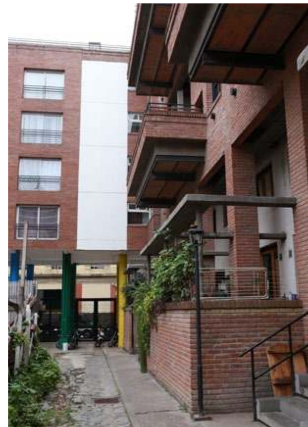
Pasillo interno de circulación
