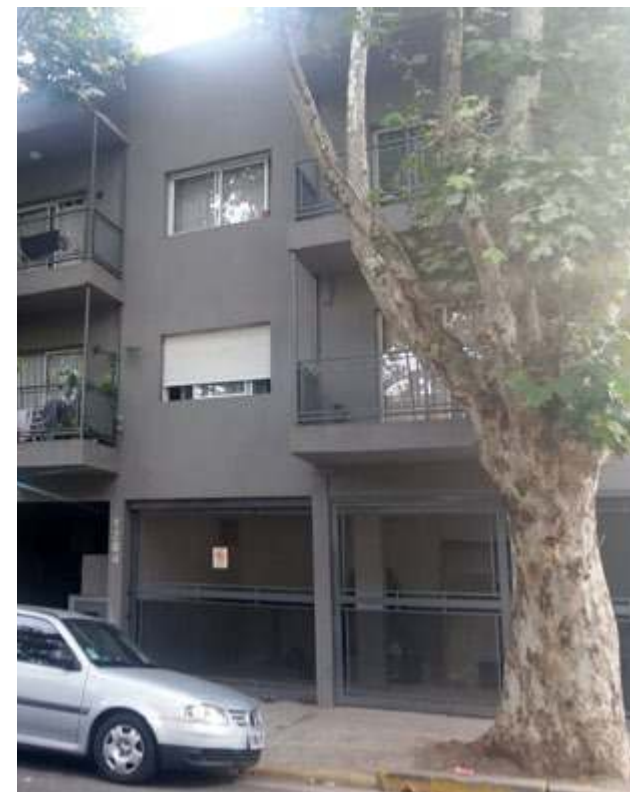
Vista lateral del edificio
