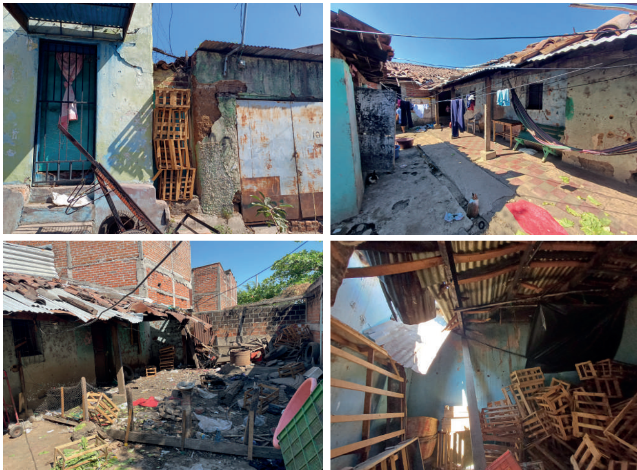
Ilustración 13. Vistas del interior y habitaciones del mesón 2.
