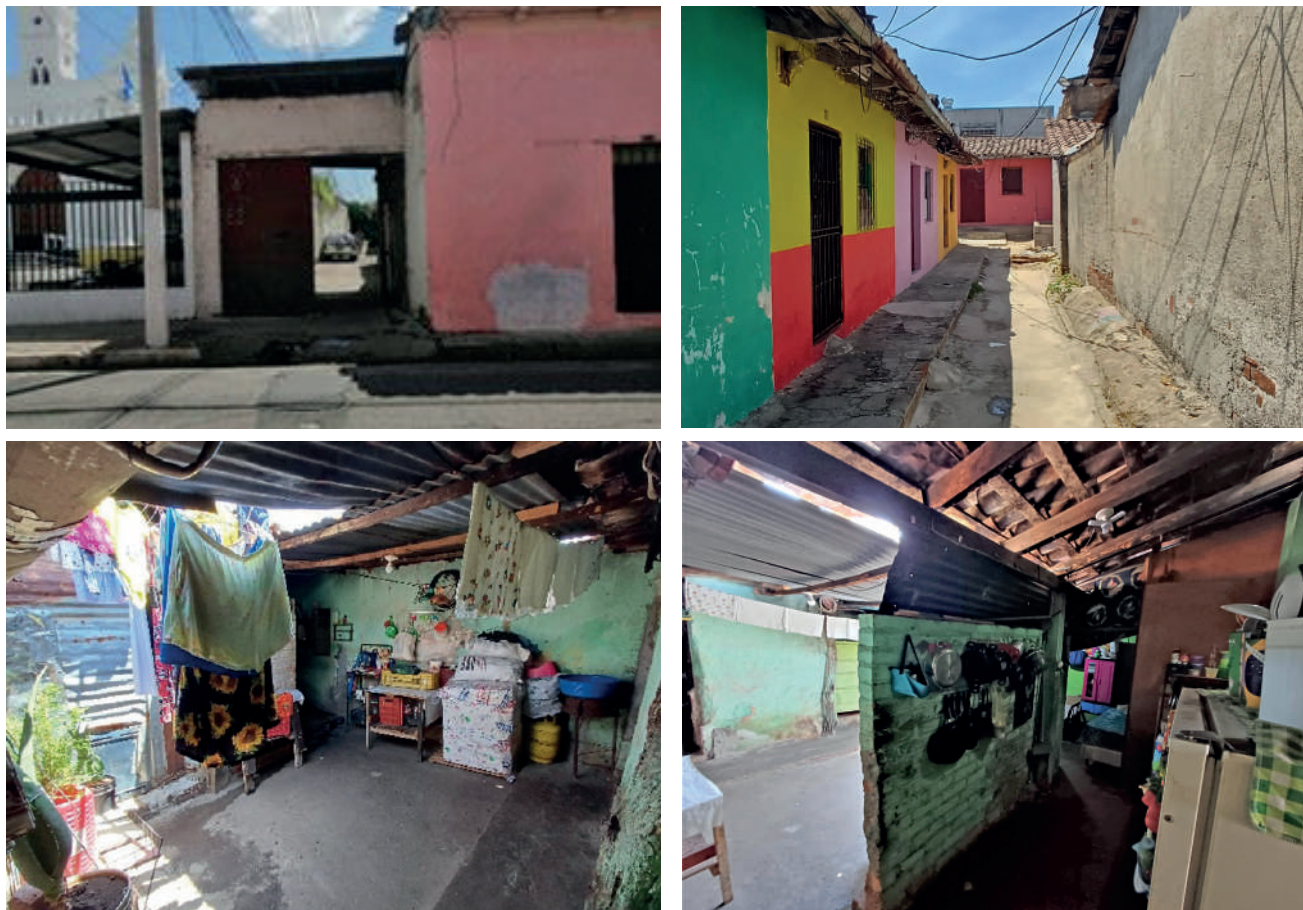
Ilustración 20. Imágenes de la fachada e interior de apartamentos 1
