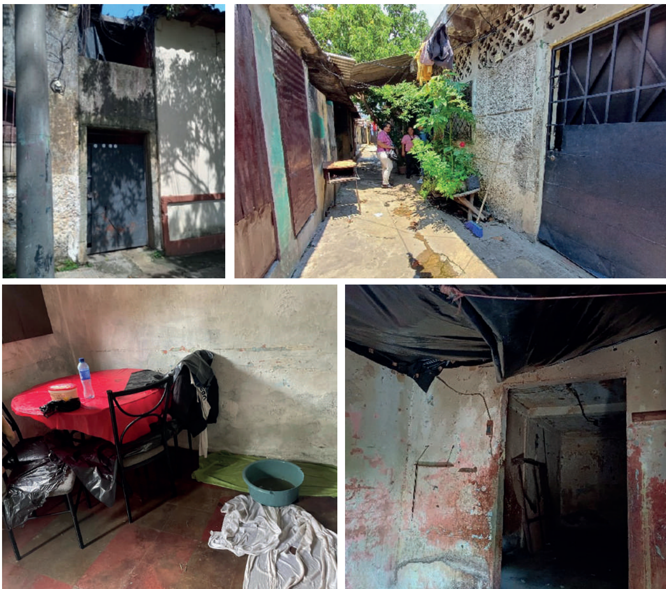
Ilustración 24. Imágenes de la fachada e interior del mesón 5.
