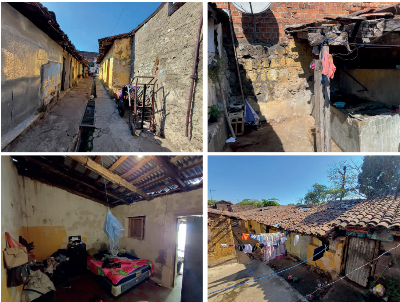
Ilustración 12. Vistas del interior y habitaciones del mesón 1.
