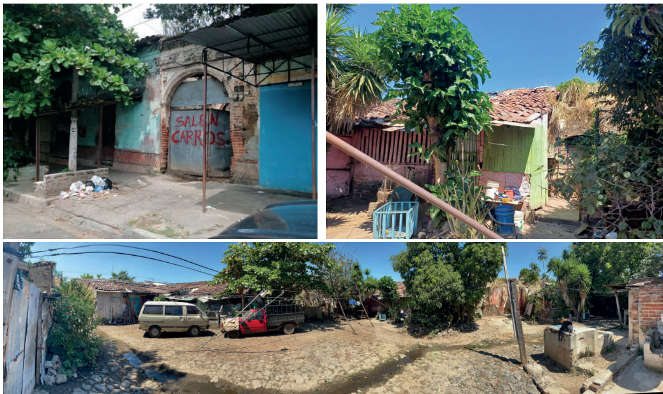
Ilustración 15. Imágenes de la fachada e interior del mesón 4.
