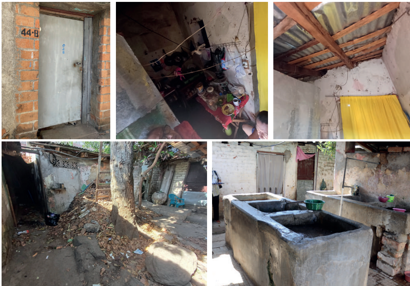
Ilustración 16. Imágenes de la fachada e interior del mesón 5.
