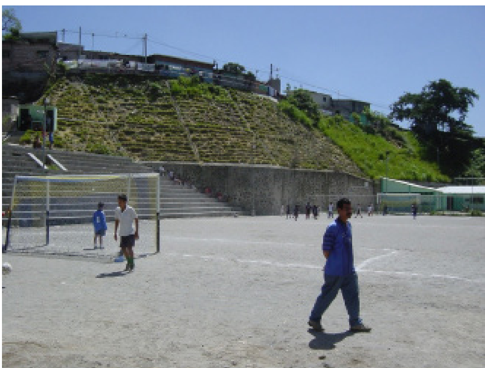
Complejo deportivo construido sobre antiguo botadero, Las Palmas. Foto/archivo FUNDASAL
