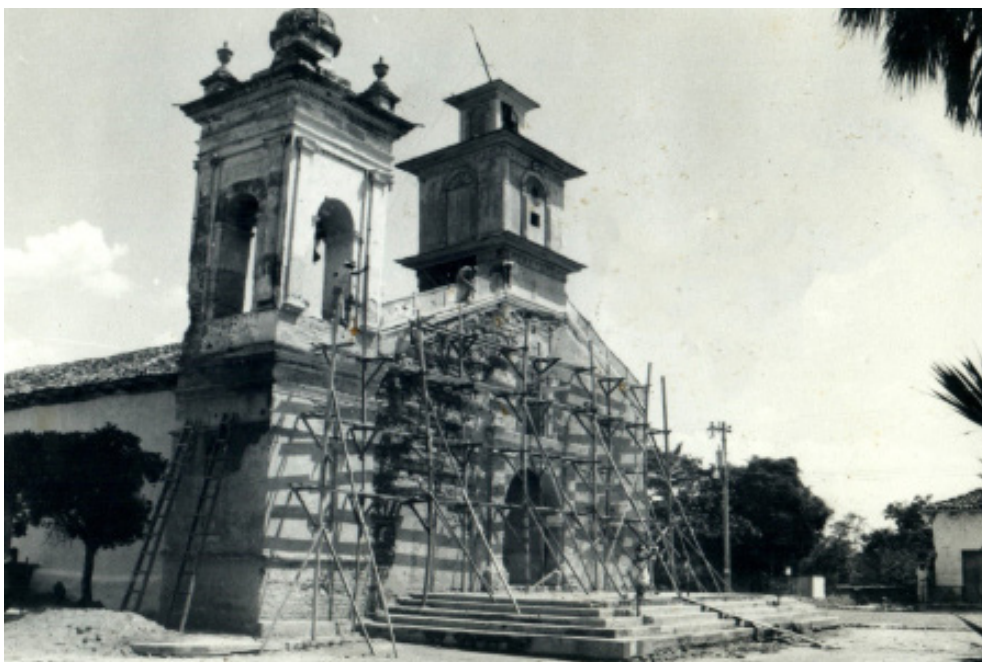
Reconstrucción de la iglesia de Tenancingo. Foto/archivo FUNDASAL
