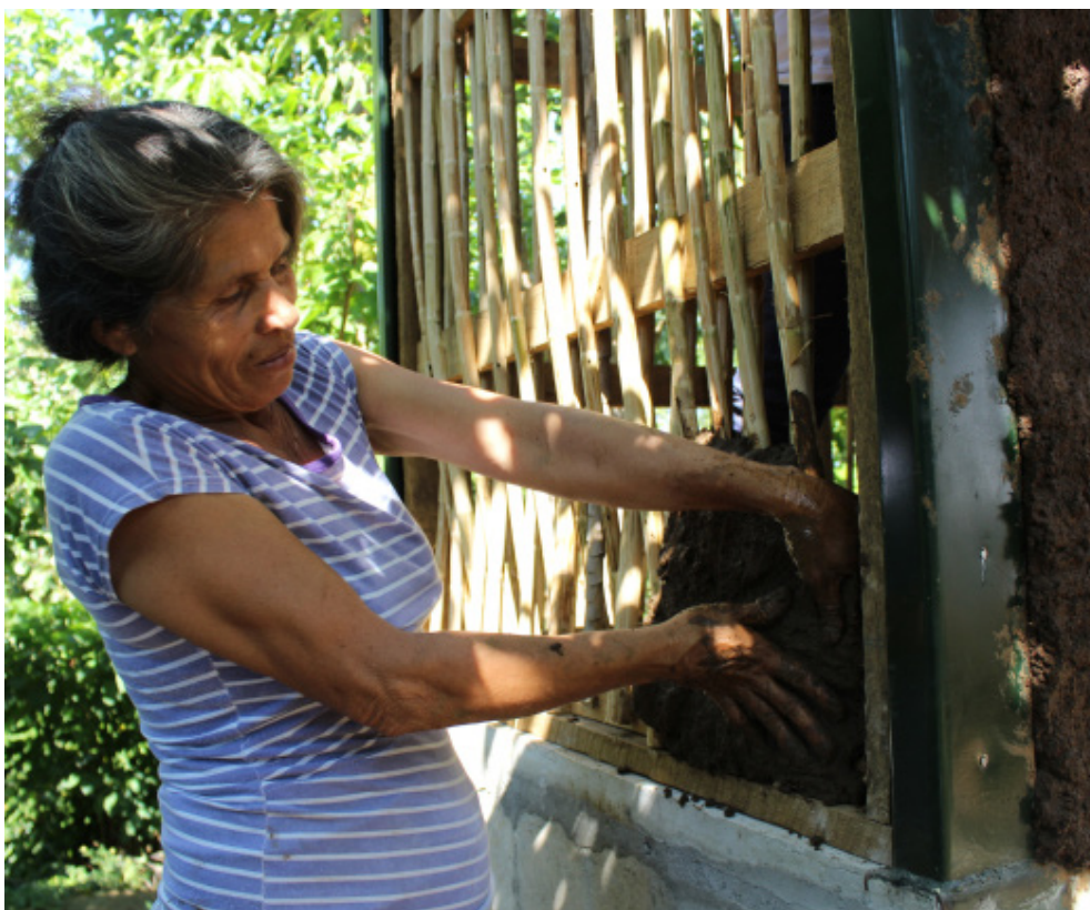
Letrina abonera con caseta de quincha prefabricada. Foto / Archivo FUNDASAL
