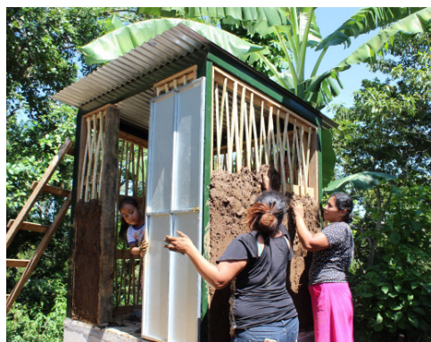
Letrina abonera con caseta de quincha prefabricada. Foto / Archivos FUNDASAL
