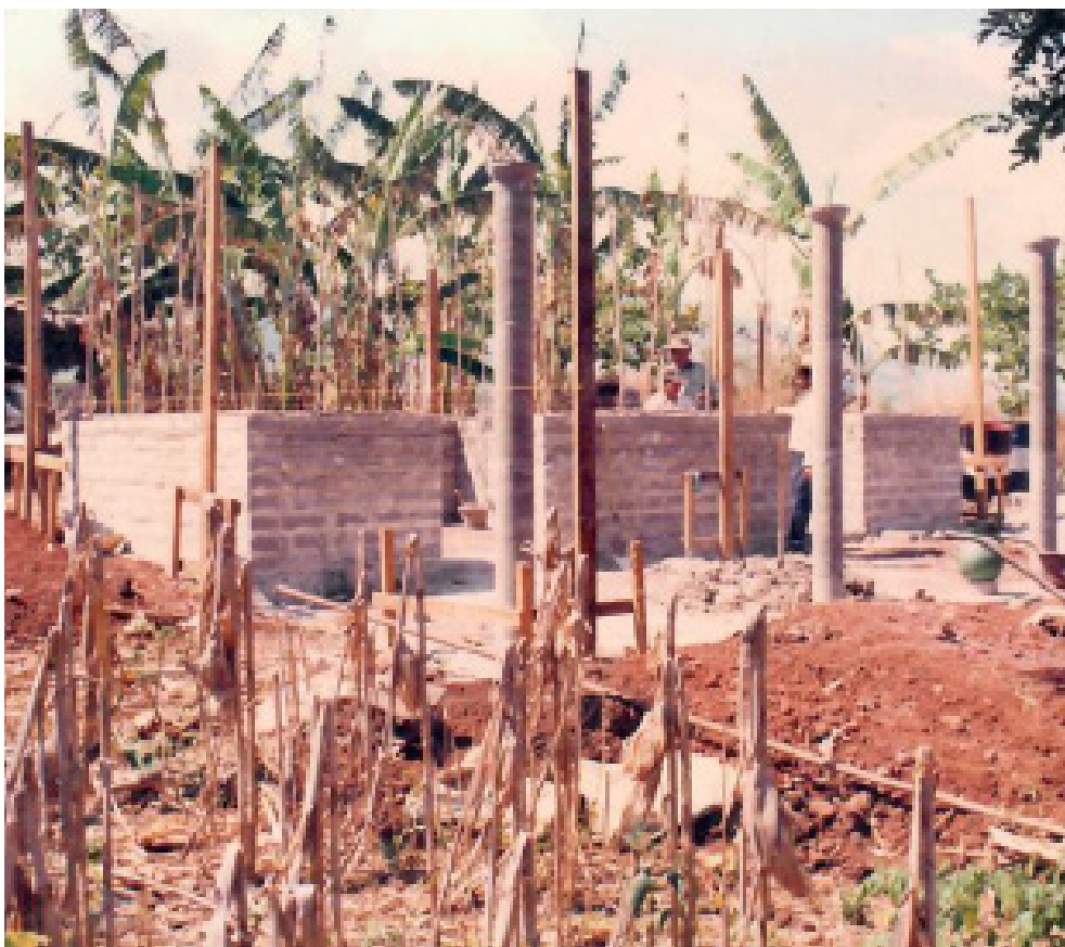
Vivienda para excombatientes en ejecución, proyecto Obsidiana. Foto/archivo FUNDASAL
