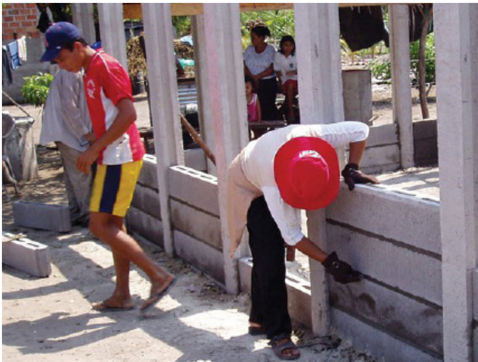
Construcción de viviendas de bloque-panel, proyecto Techando la Paz. Foto/ World Habitat Awards
