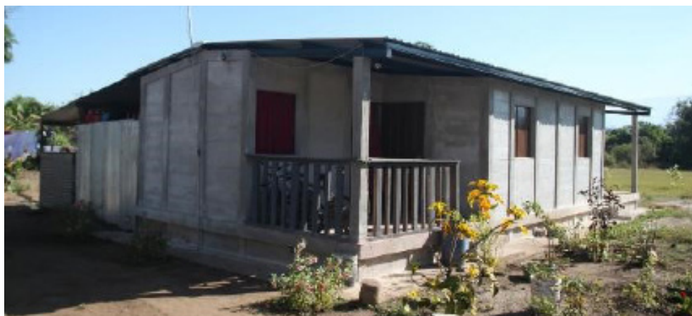
Vivienda elevada, proceso y producto final, modelo para zonas inundables puesta en marcha en Sacacoyo, La Libertad. Foto / Archivo FUNDASAL
