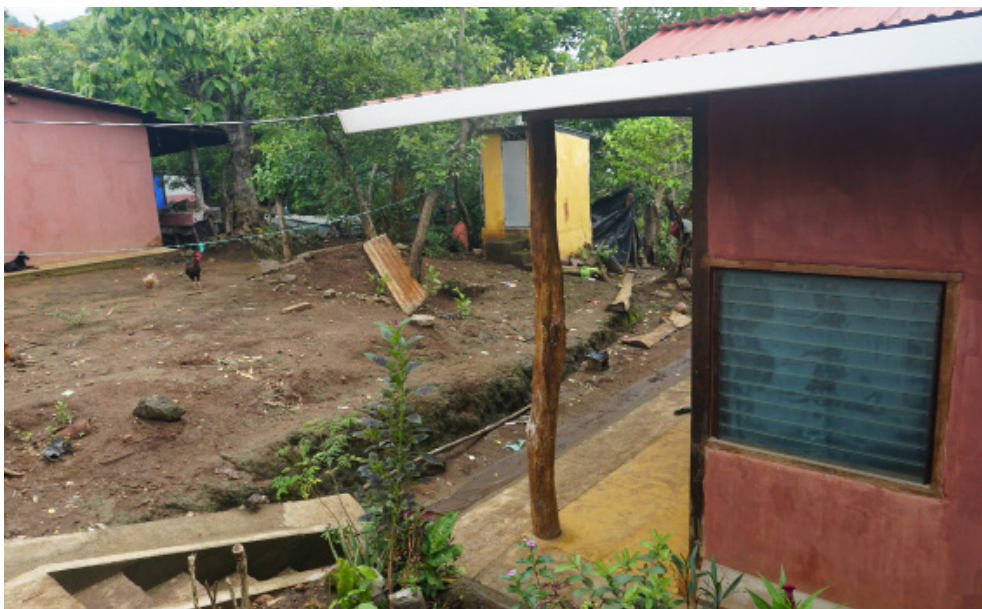
Producto final de vivienda de adobe mejorado, la original fue demolida. Foto / Archivo FUNDASAL
