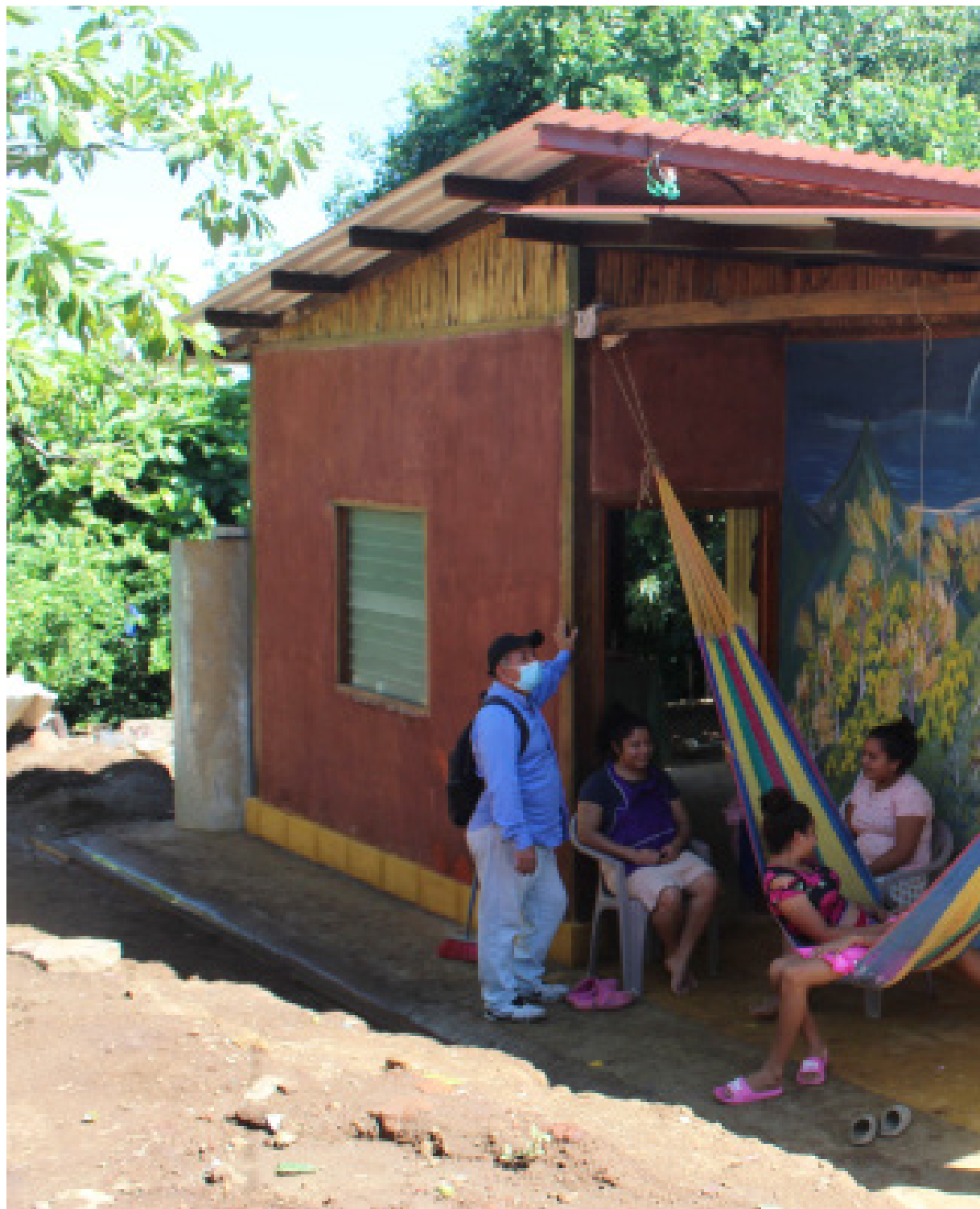
Producto final de vivienda de adobe mejorado. Foto / Archivo FUNDASAL
