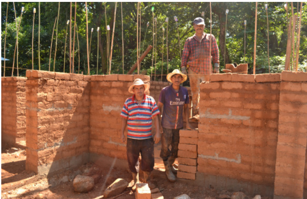
Construcción con tierra en San Pablo Tacachico, La Libertad. Foto /Archivo FUNDASAL
