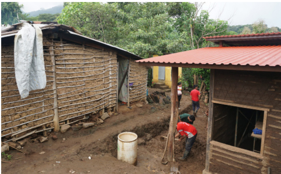
Vivienda original (izquierda) y vivienda nueva en construcción con el sistema de adobe mejorado (derecha) Foto/archivo FUNDASAL
