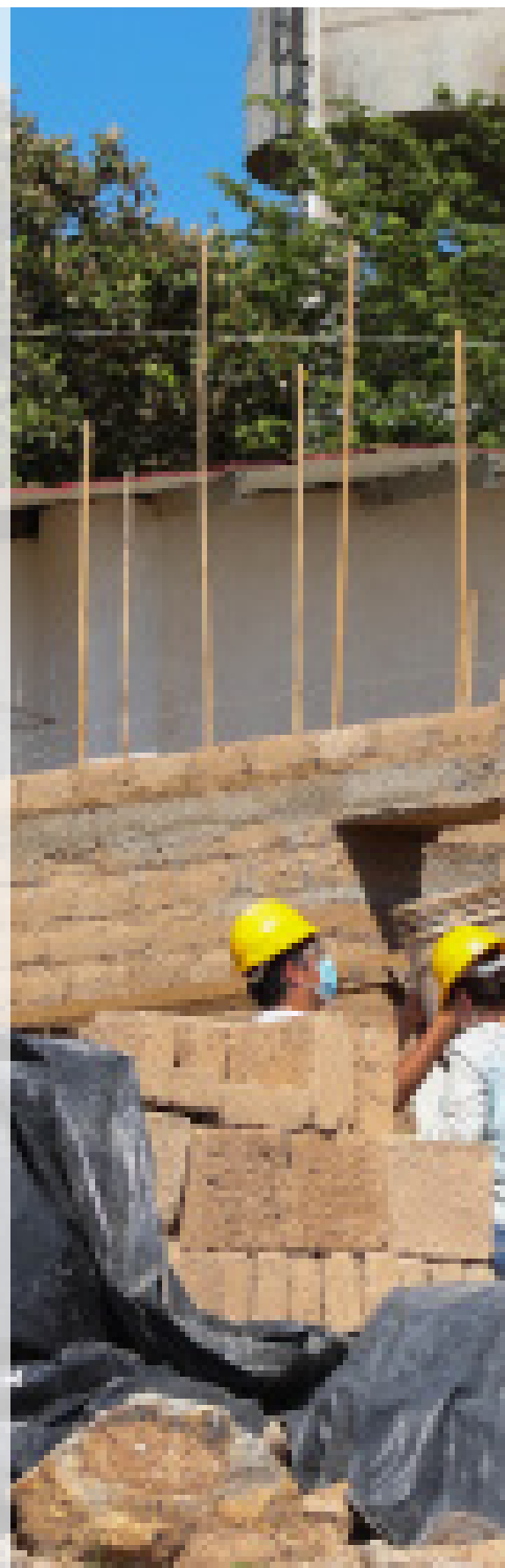
Confección de las primeras viviendas de Acovicupa con adobe sismorresistente. Foto / Archivo FUNDASAL
