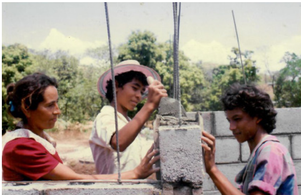
Proceso constructivo durante repoblamiento de Santa Marta, Cabañas. Foto/ Archivo FUNDASAL
