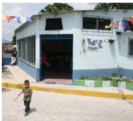
Centro comunitario Nueva Esperanza, Soyapango, proceso y final, programa Mejoramiento de Barrios. Foto/archivo FUNDASAL
