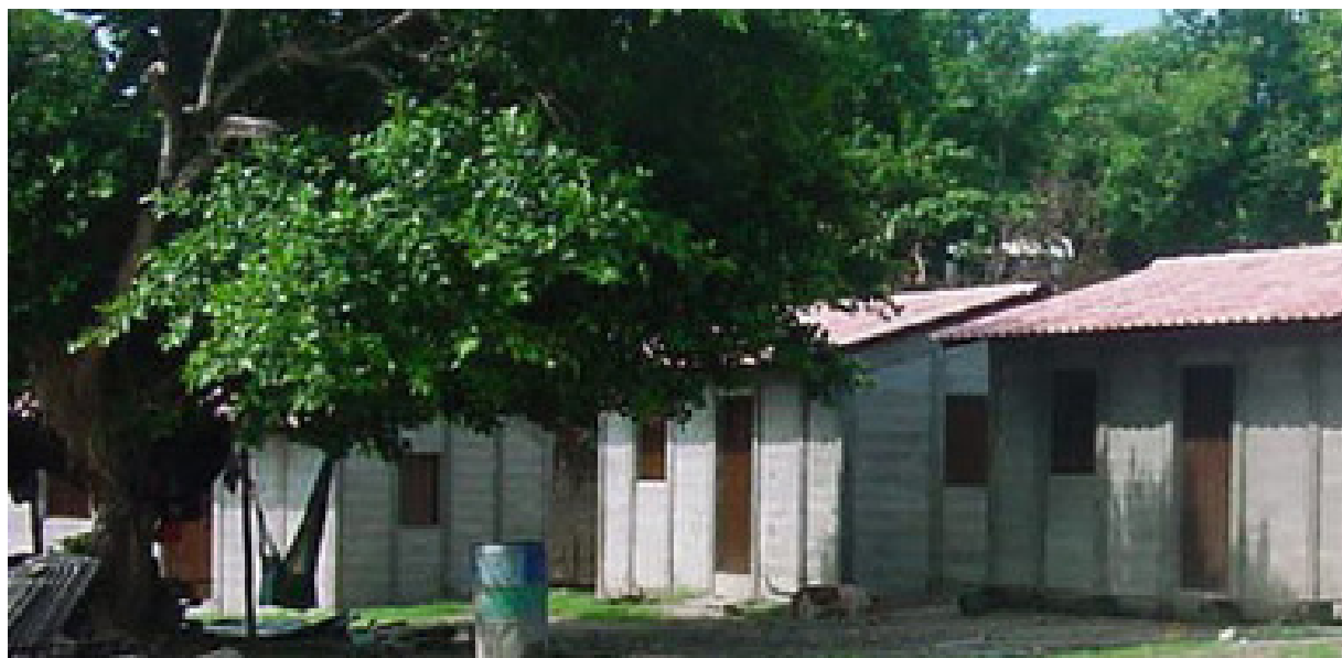
Construcción de viviendas de bloque-panel, proyecto Techando la Paz. Foto/ World Habitat Awards
