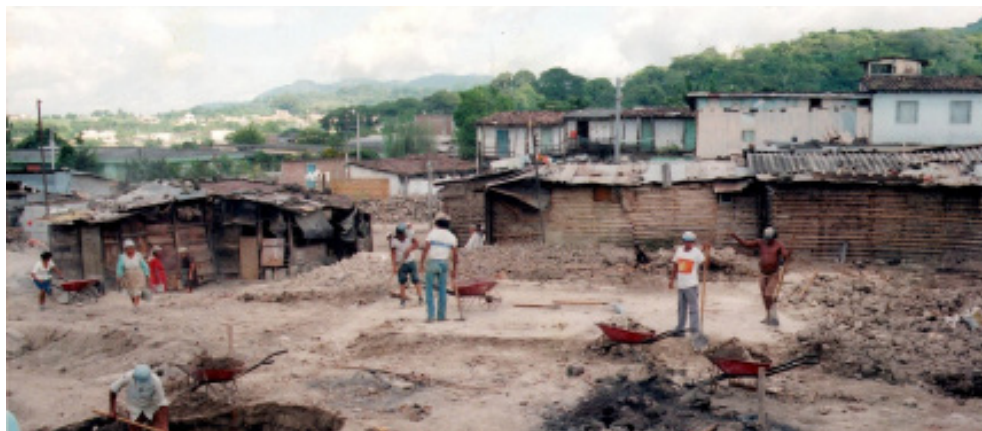
Desmontaje de viviendas provisionales, comunidad Lupita, Antigua Cuscatlán. Foto/archivo FUNDASAL.
