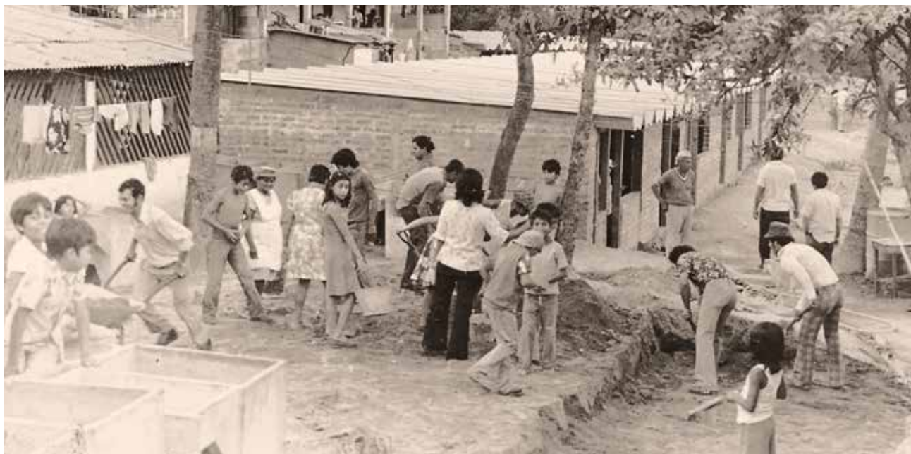
Construcción del Mesón El Progreso bajo el modelo de ayuda mutua.
