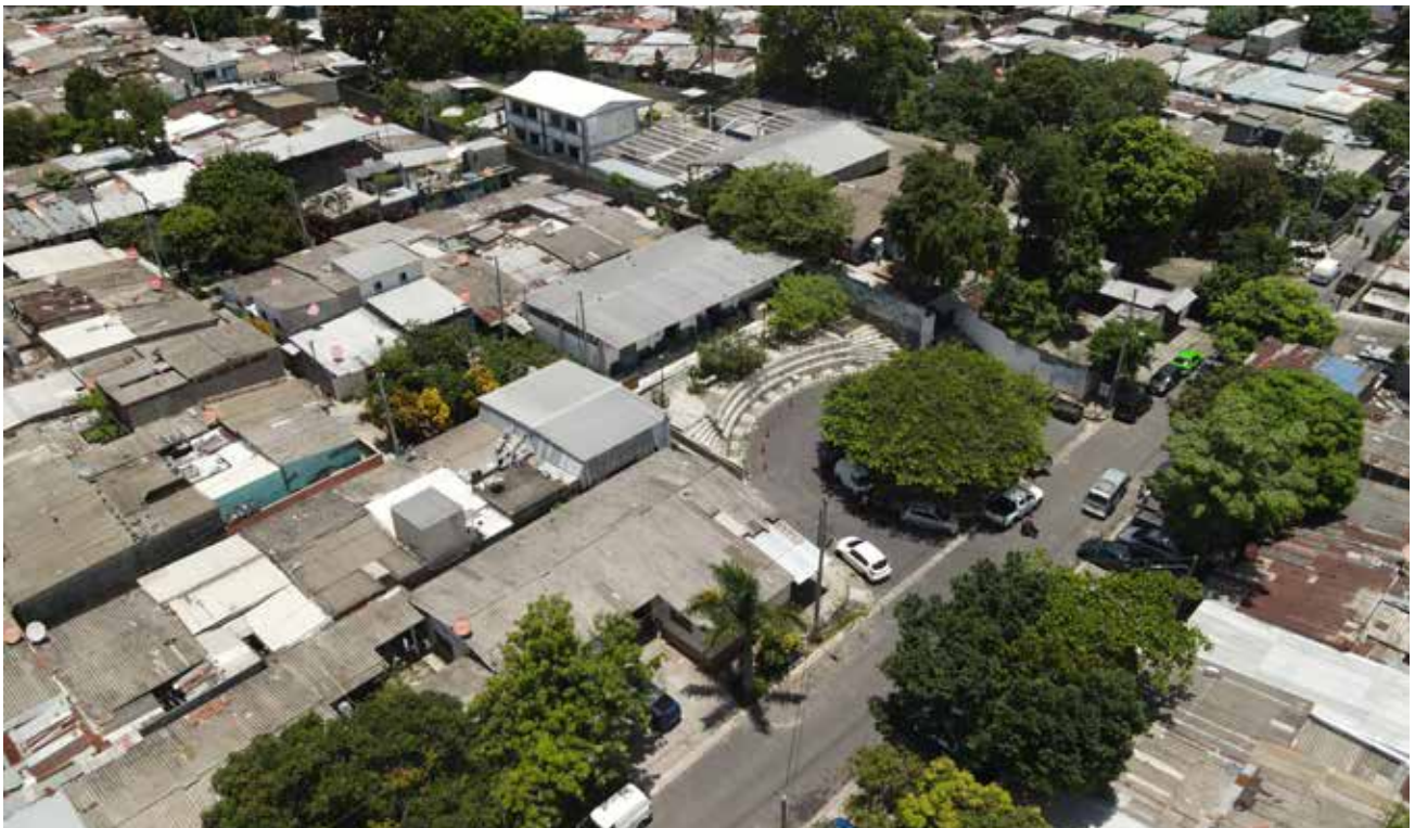
Vistas aéreas del proyecto San José del Pino, Santa Tecla. 525 viviendas.
