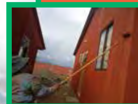
Obra: Viviendas de interés social, Senkata Grupo: Estrellas de la Pintura y Arco Iris
