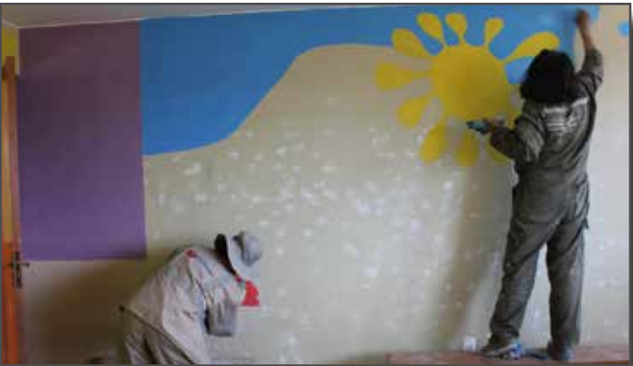
Compañeras pintando el centro comunal de Kenanipata como parte de su proceso de capacitación.
