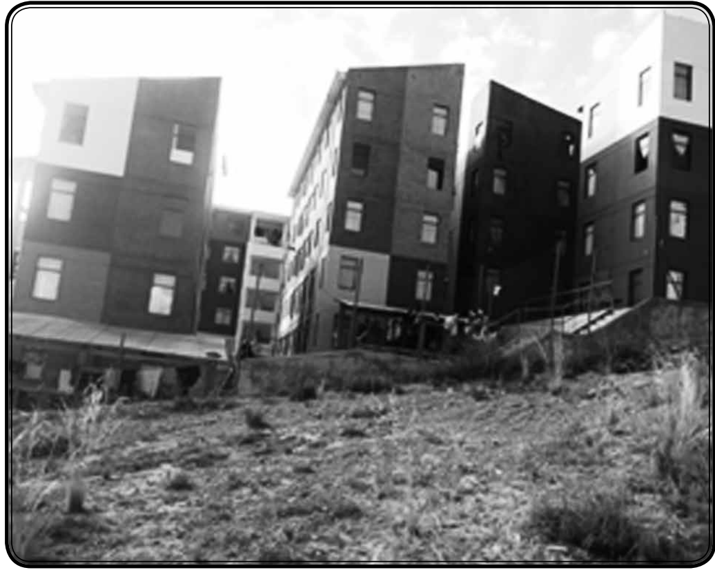
Muchos bloques tienen problemas de asoleamiento y ventilación.
