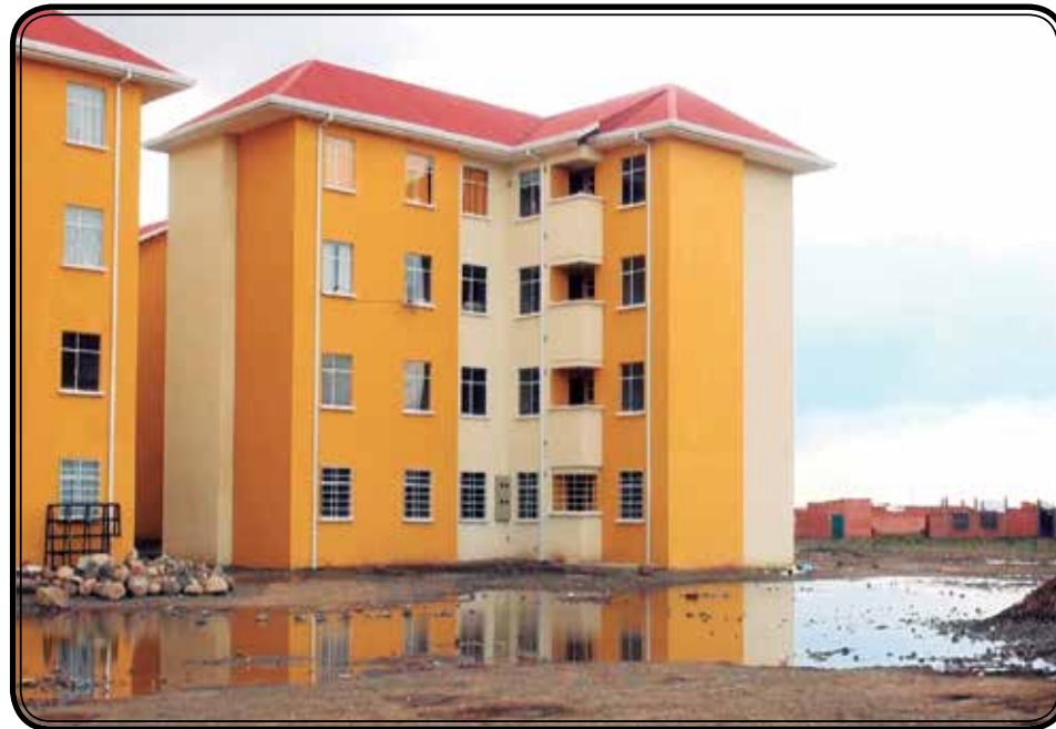
Problemas en el drenaje pluvial
