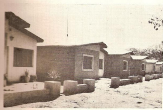
Vista de otro grupo de viviendas del Plan de Ayuda Total (C), construidas con bloques de hormigón. (Adviértase la mejor armonía de sus líneas).
