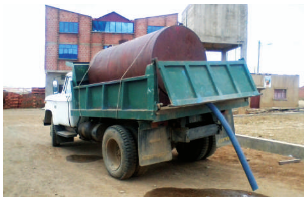
(Foto archivo propio) zona Chañocahua, carro aguatero transportando agua para construcción.
