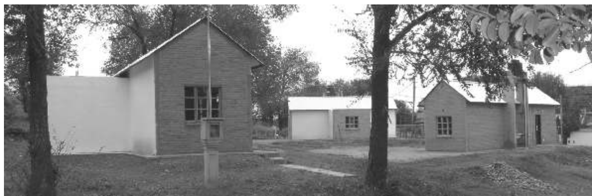
Viviendas terminadas en la Municipalidad de Villa Allende.
