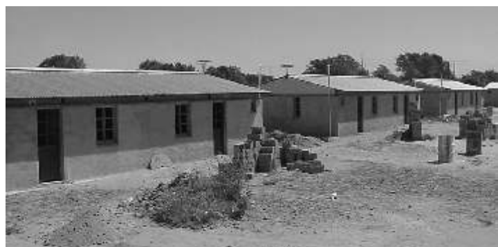
Municipalidad de Río Cuarto- Córdoba. Asentamientos San Cayetano y La Colmena- 39 viviendas Sistema UMA.
