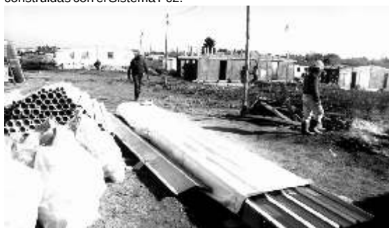
Con tecnología mixta, en la que se utilizaron paneles de muro FC2, se construyeron dos planes de 88 y 12 viviendas, financiados por la IMM y ejecutados por la empresa constructora CEAOSA.
