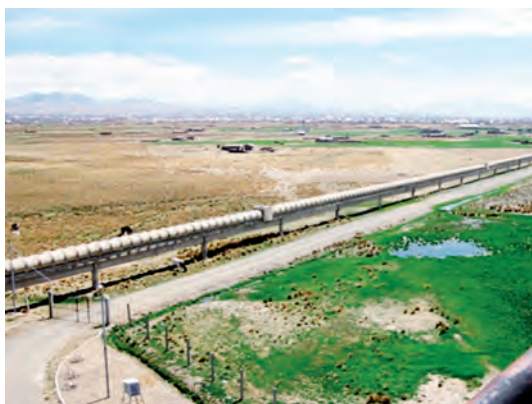
Fuente: P.T.A.R. de Puchucollo, Emisario principal Fotografía: EPSAS
