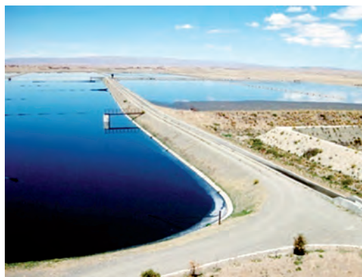
Fuente: P.T.A.R. de Puchucollo, Lagunas Anaeróbicas Fotografía: EPSAS
