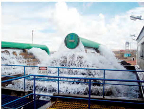
Fotografía: Archivo Red Hábitat / Proceso de Aireación Sistema El Alto
