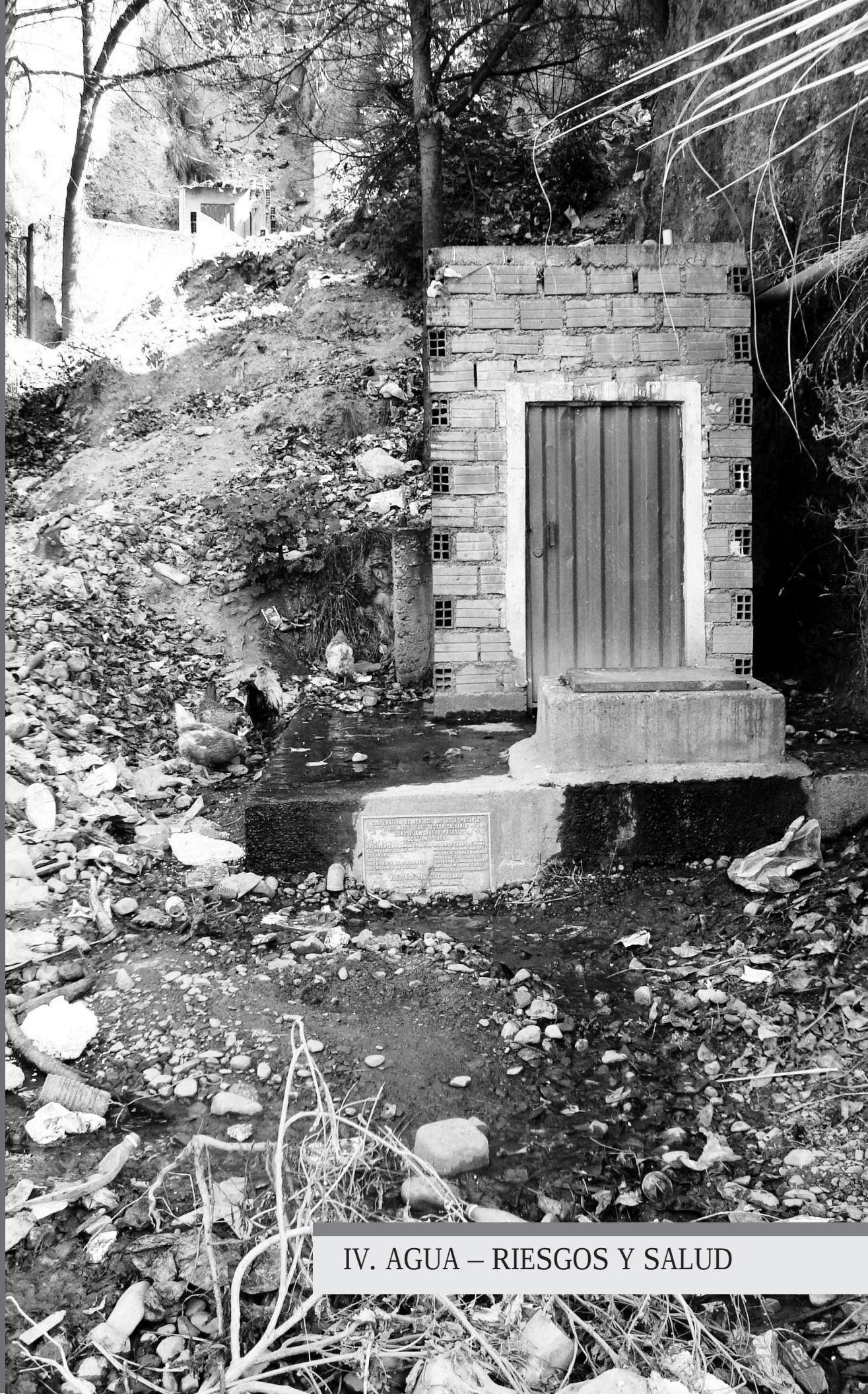
Foto: Red Hábitat, tanque de agua y caseta de cloración de la cooperativa 3 de Mayo, Distrito 5, Cotahuma.
