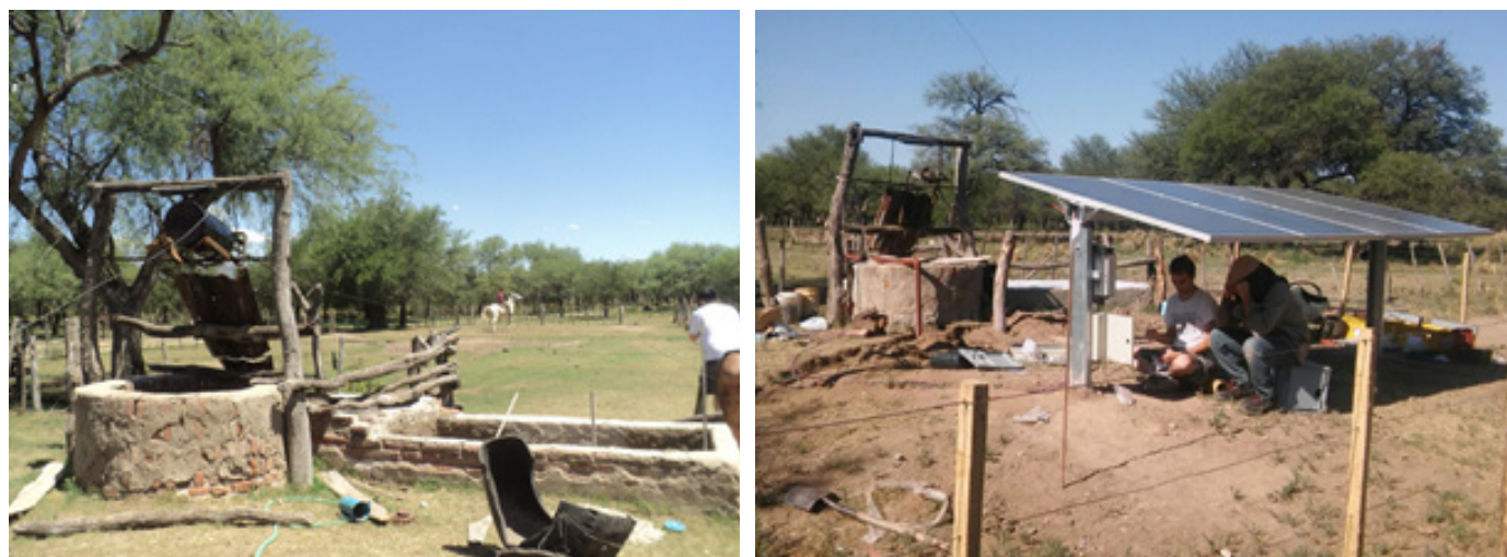
Fig. 6. Balde y volcador tirado a caballo Pje San Isidro. Fuente Mario Riso (izq.). Configuración Sistema de bombeo fotovoltaico. Fuente Marcela Ledesma (der).
