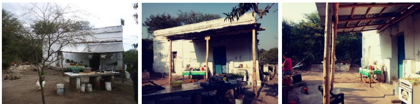
Fig.5. Refuncionalización y reciclaje de la galería existente para espacio de producción apícola. El antes (izq) y después (der). Fuente: propia.
