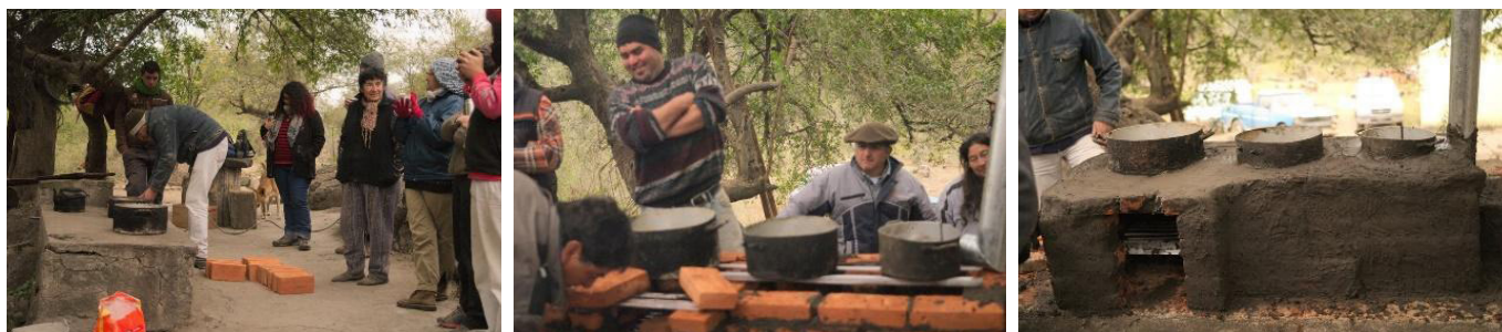
Fig. 3. Proceso de construcción de la cocina mejorada de alto rendimiento y bajo consumo. Fuente: propia.
