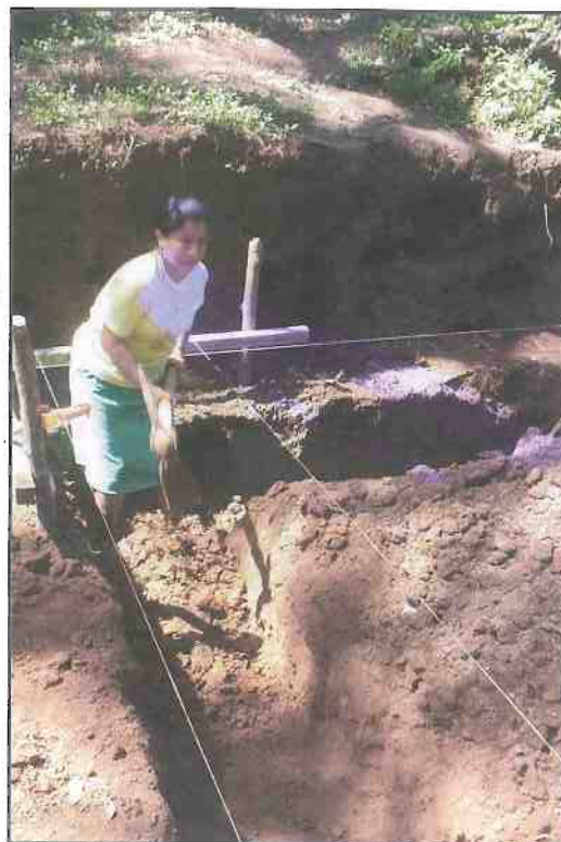
Una cooperativista cavando zanjas, para los cimientos de su casa
