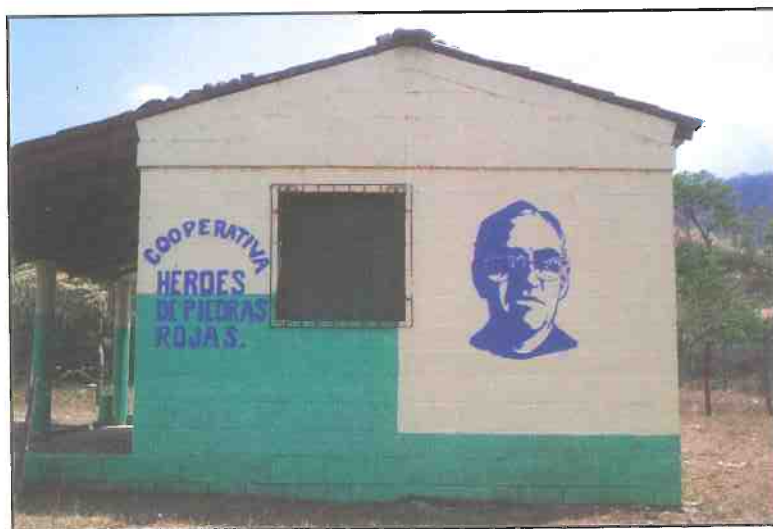
Salón Comunitario, vistas lateral y frontal.
