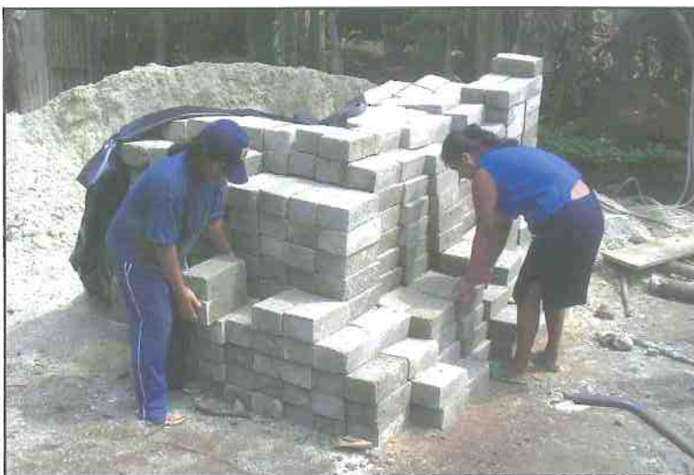
Socias apilando ladrillos.
