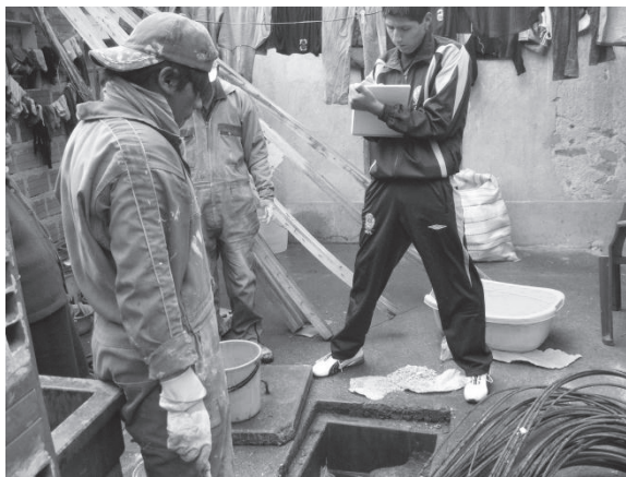
Un vecino ayuda en la ejecución de la prueba hidráulica domiciliaria
