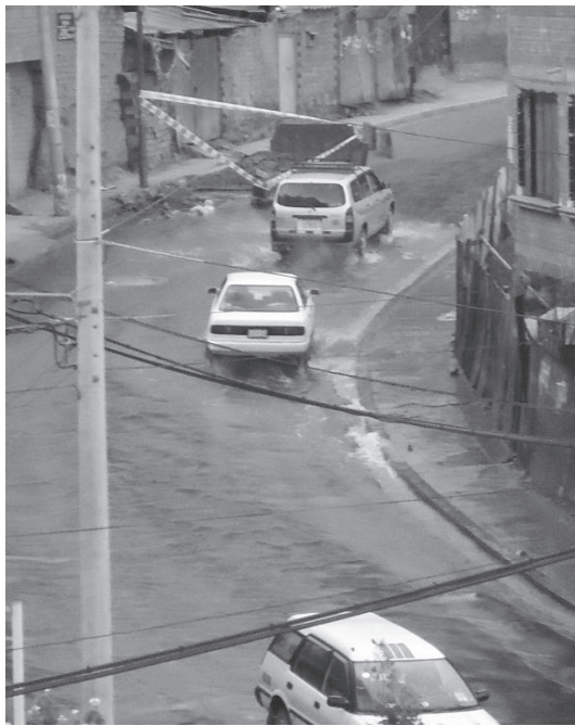
Perdida de agua por fallas en las cañerías. Se deja pasar horas hasta solucionar el problema.
