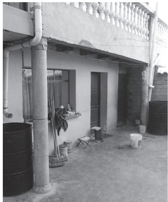
Sistema de cosecha de agua en envases de metal.
