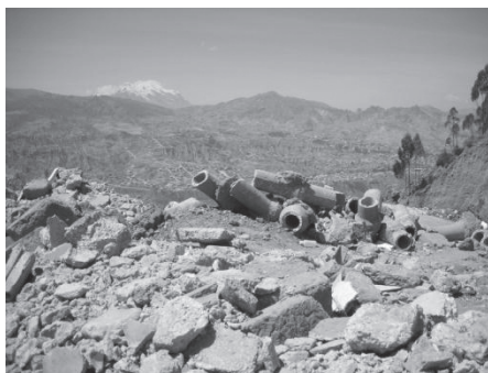
Una vista de los escombros tras el cambio del sistema de alcantarillado domiciliario
