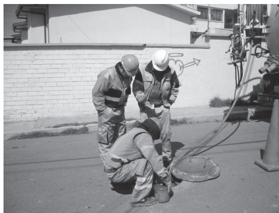
Personal de EPSAS efectúa la prueba hidráulica en las matrices de la red de alcantarillado
